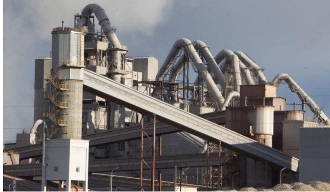
Imagen 2: Fábrica de elaboración de cemento
