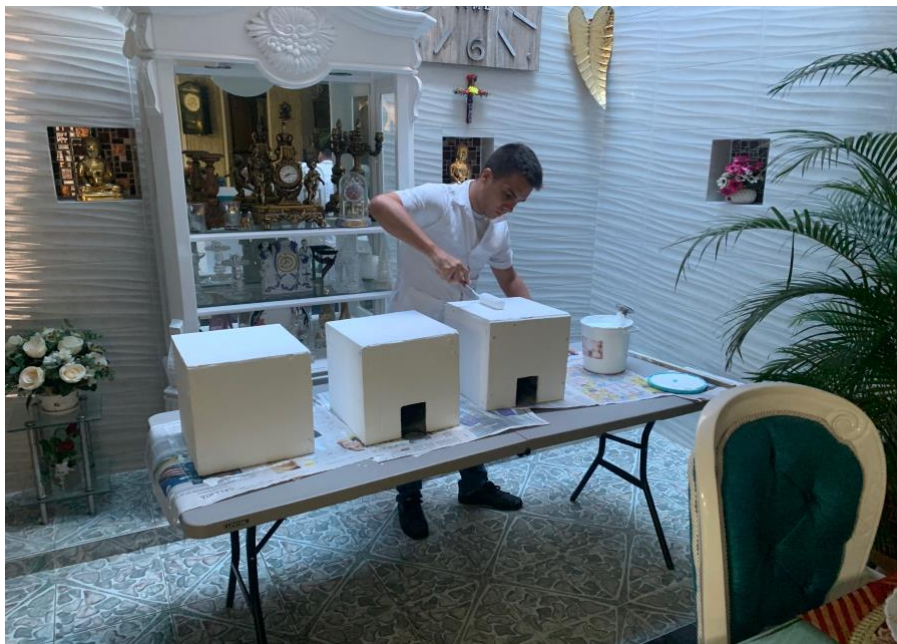
Figura 2. Aplicación de Super Therm
