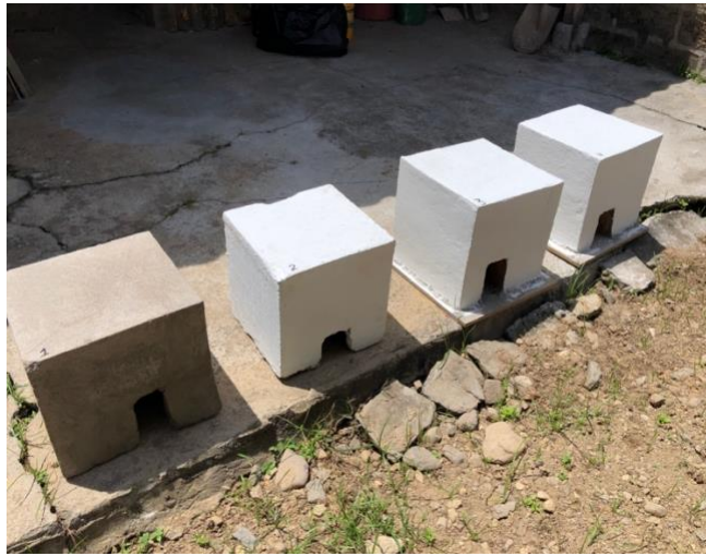
Figura 27. Módulos de ladrillo macizo finalizados
