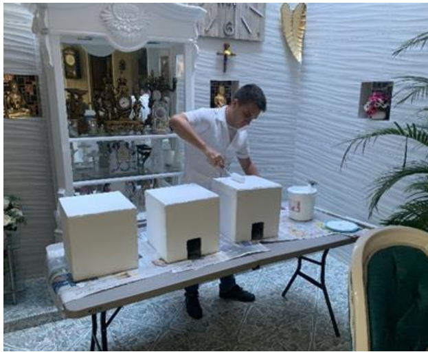
Figura 23. Aplicación de aislante térmico sobre módulos Súper Board.
