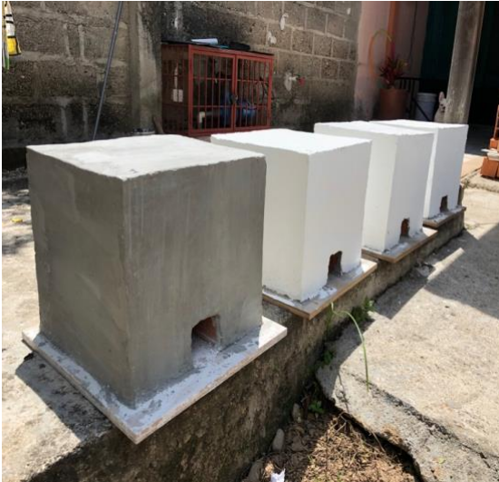
Figura 25. Módulos de ladrillo H10 finalizados
