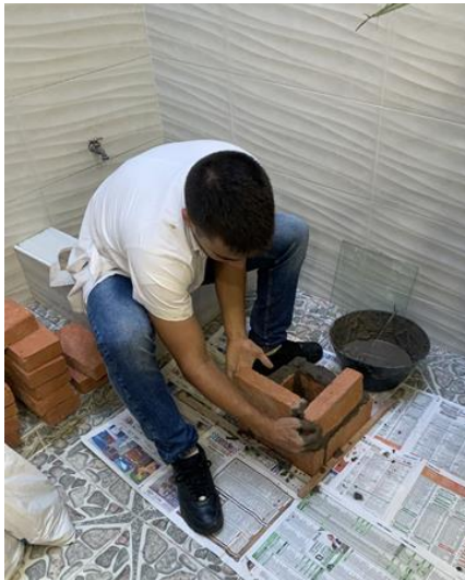
Figura 13. Pega con mortero de ladrillos macizos
