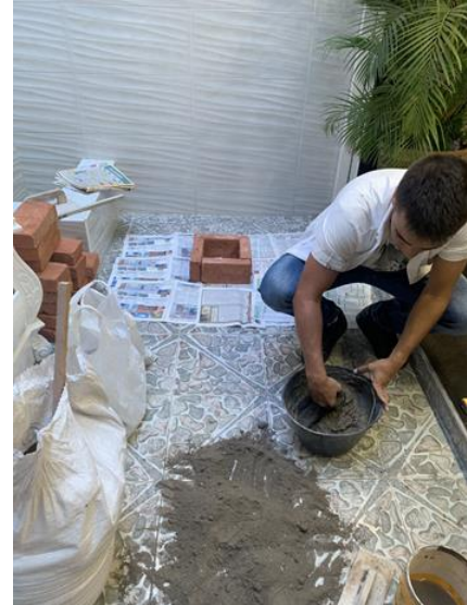
Figura 12. Inicio de pega de ladrillos macizos.
