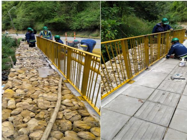
Figura 31. Anclaje con adhesivo y varilla de refuerzo 5/8”x17 cm
