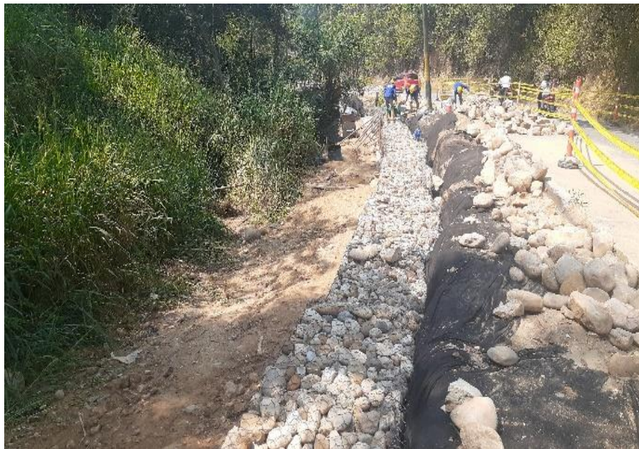
Figura 22. Construcción del gavión para estabilidad del andén
