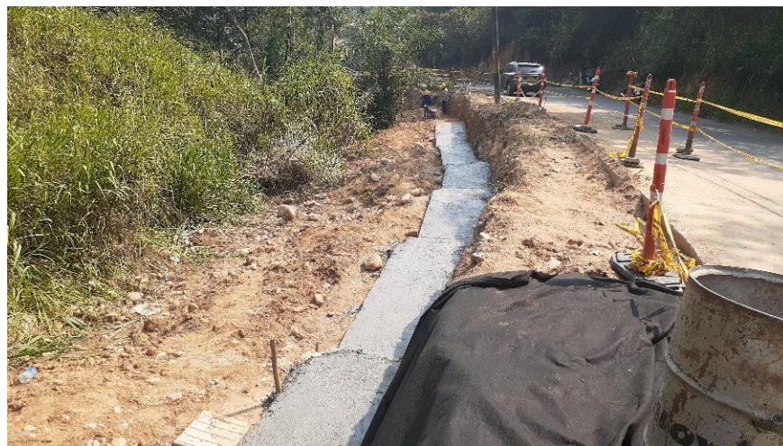
Figura 21. Suministro de concreto de 2000 psi
