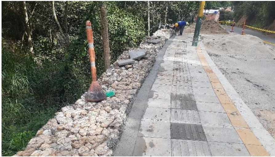
Figura 26. Instalación de confinamiento Bordillo
