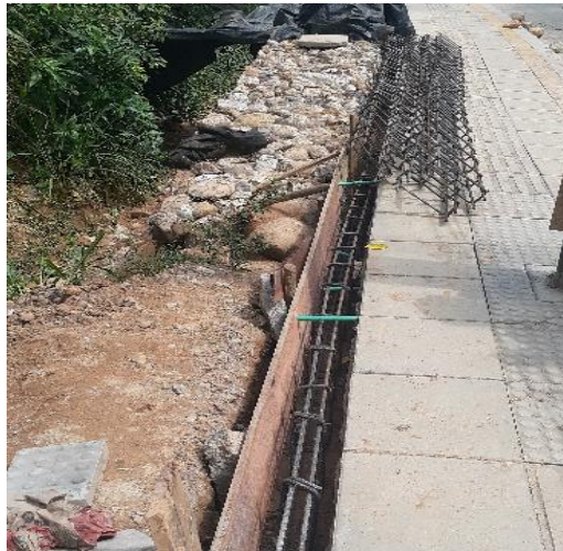
Figura 25. instalación de acero para placas y bordillos
