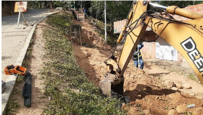
Figura 20. Relleno para cimentación de los muros de gavión
