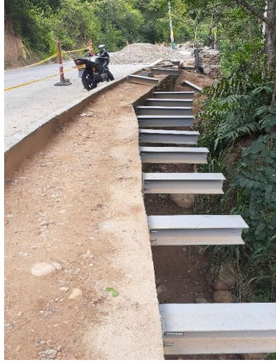
Figura 32. Instalación de Barandas.
