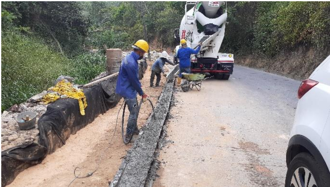
Figura 23. Instalación del bordillo de concreto
