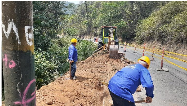
Figura 19. Excavaciones para la cimentación
