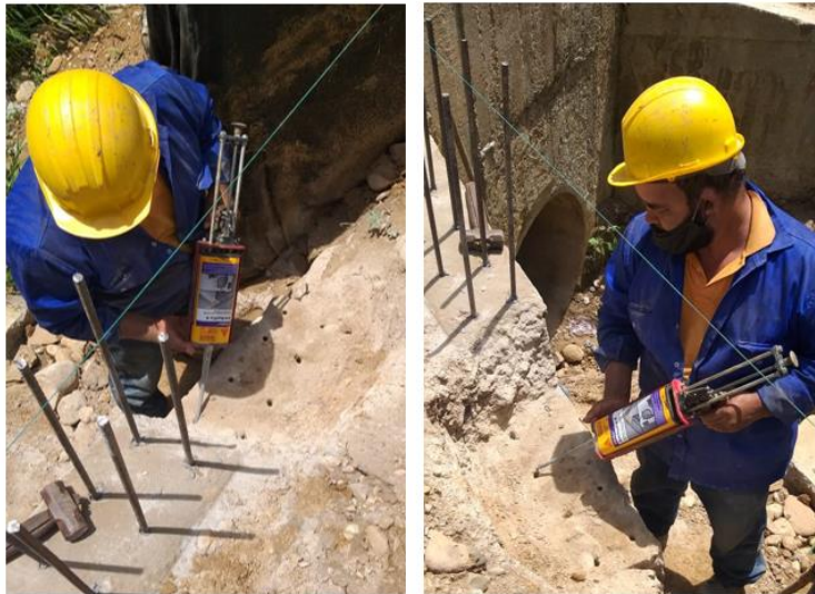
Figura 27. Instalación de aleros para la construcción de la placa de concreto
