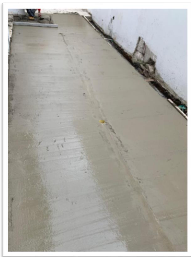
Figura No. 28. Fundición del mortero de nivelación
