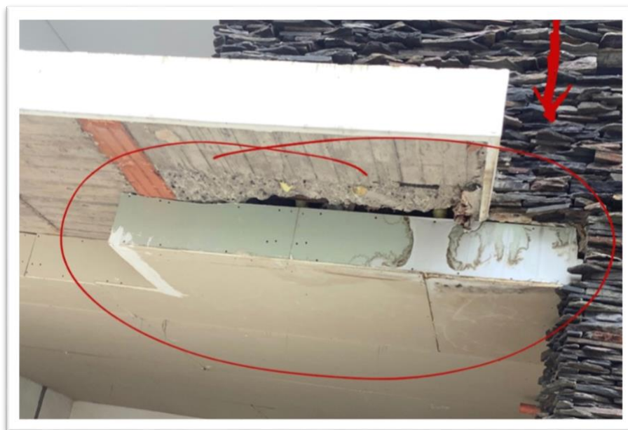
Figura No. 17. Cielo Raso del Parqueadero
