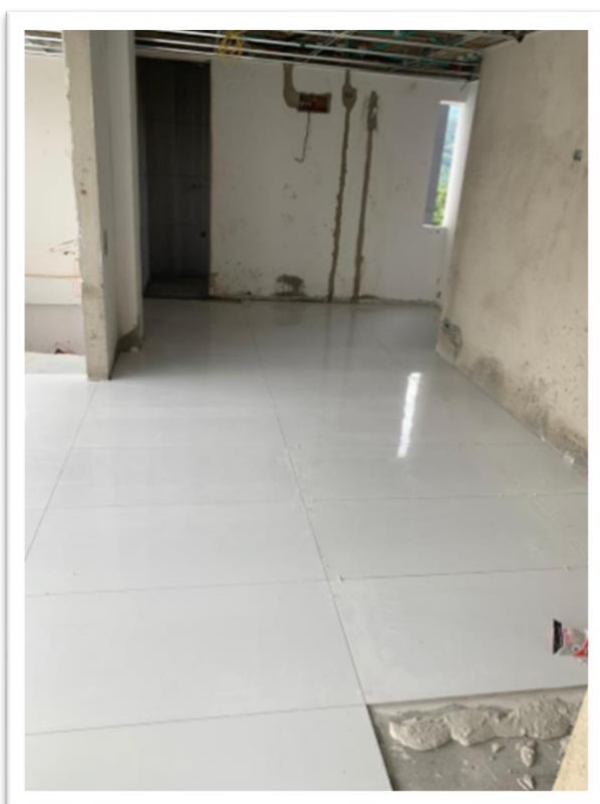
Figura No. 35. Enchape de los internos del segundo nivel
