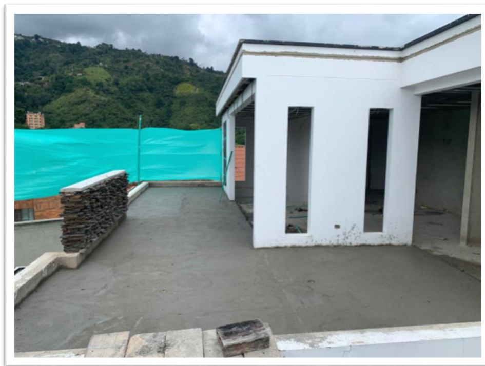
Figura No. 33. Fundición de morteros del tercer nivel de las edificaciones
