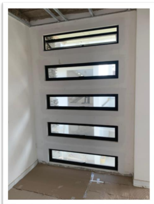
Figura No. 46. Instalación de ventanas
