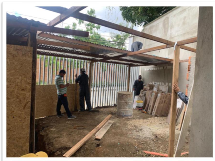
Figura No. 6. Adecuación del campamento
