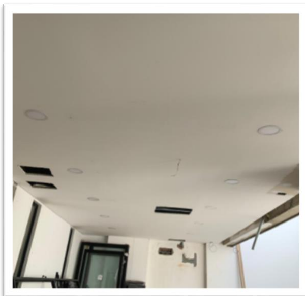
Figura No. 41. Instalación de luminarias
