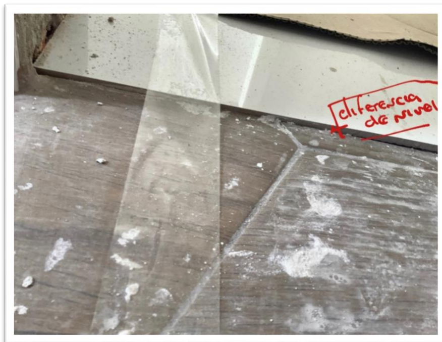
Figura No. 19. Diferencia de nivel
