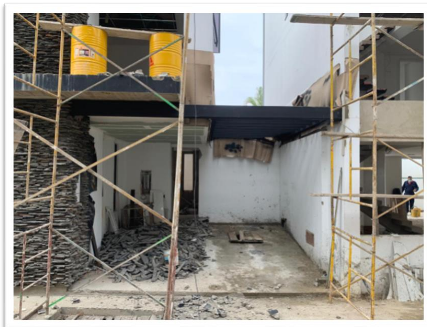
Figura N. 45. Instalación de cubiertas de parqueaderos
