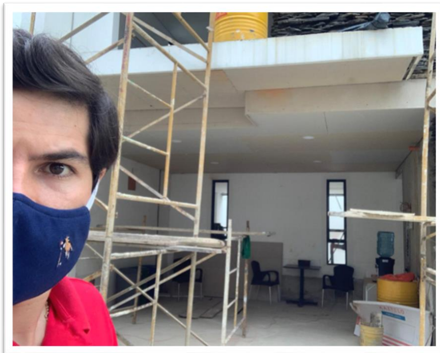
Figura No.29. Instalación de láminas de eterboart
