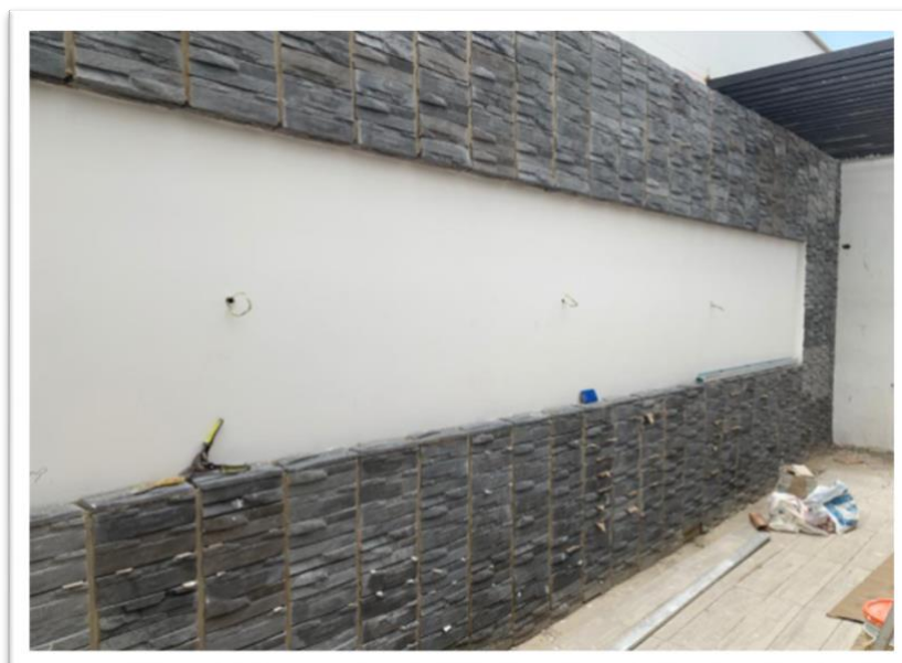
Figura No. 42. Construcción de acabados del patio modelo.
