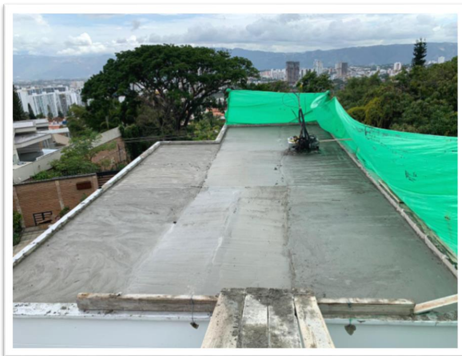
Figura No. 22. Mortero impermeabilizado
