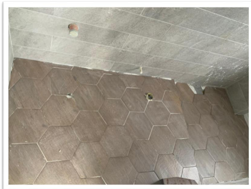
Figura No. 36. Enchape de baños
