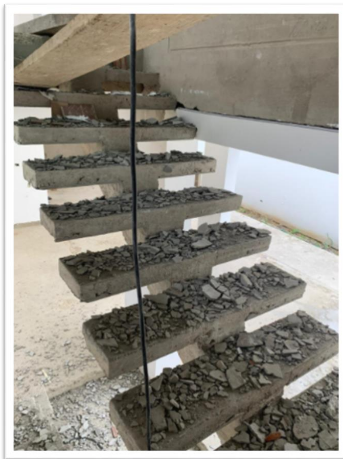
Figura No. 25. Demolición
