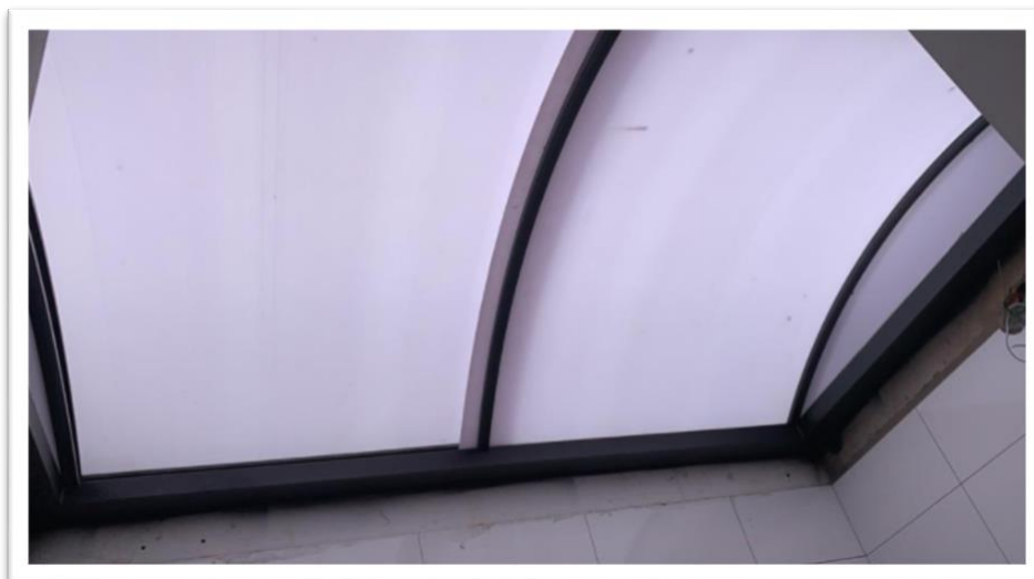
Figura N. 44. Instalación de domos
