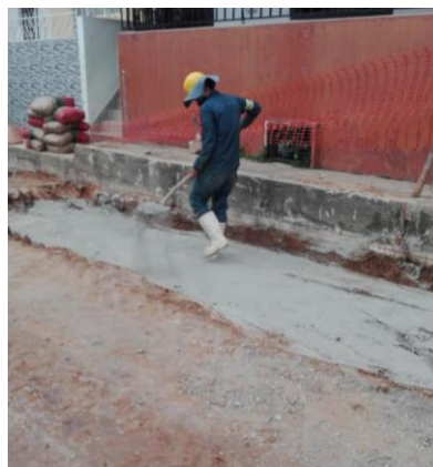
Figura 17. Mejorando la subrasante con cemento.
