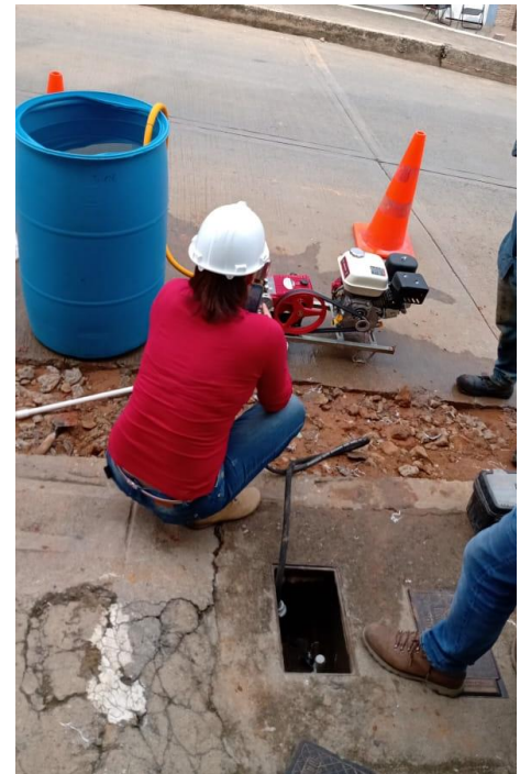
Figura 6. Prueba hidráulica y desinfección.
