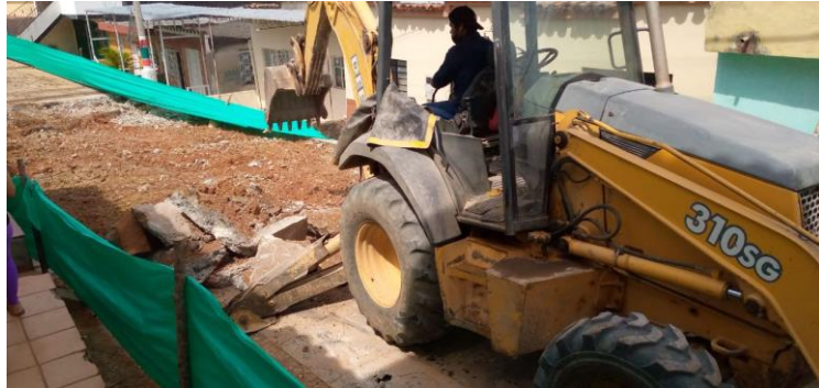
Figura 13. Retiro de escombros y cajeo.
