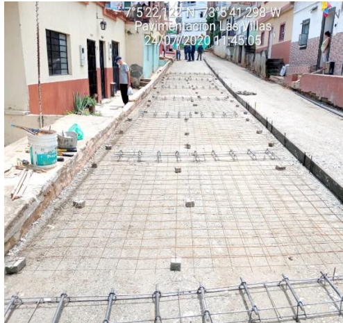
Figura 18. Canastillas y mallas para la pavimentación.
