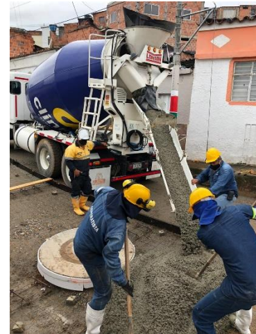
Figura 19. Concreto en obra, fundida.
