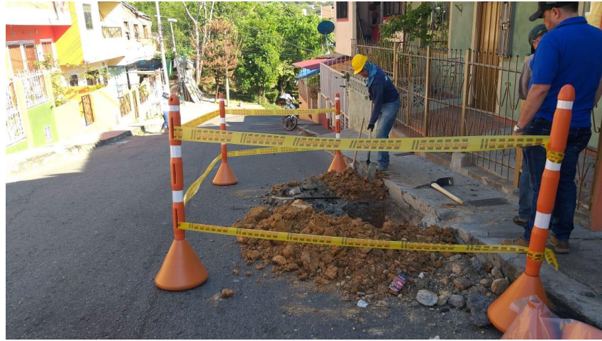
Figura 4. Realización de apique.
