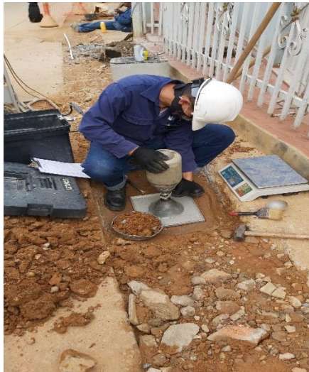
Figura 15. Ensayo de cono de arena a la subrasante.
