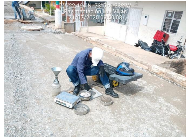
Figura 16. Ensayo de cono de arena a la base.
