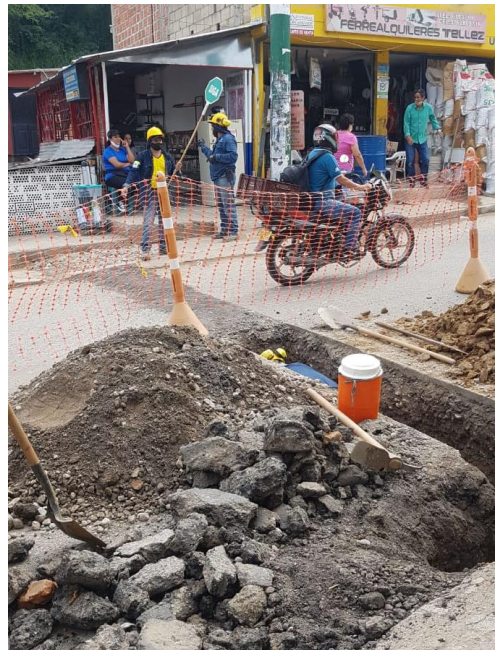
Figura 5. Excavación para la instalación de tubería.
