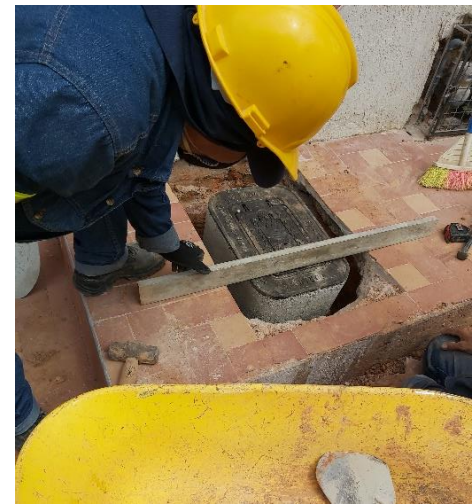
Figura 9. instalación de cajas para domiciliarias.
