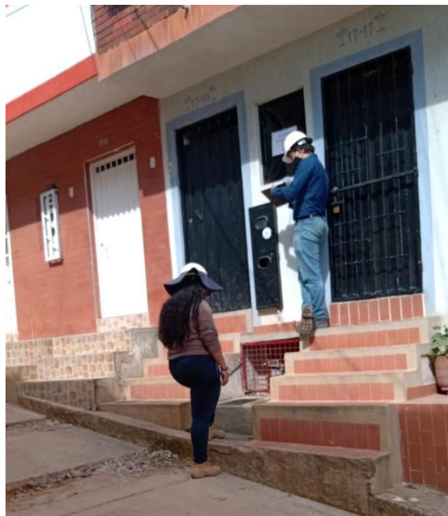
Figura 3. Realización de actas de vecindad.
