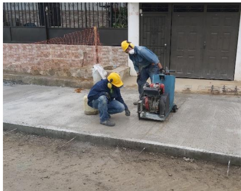
Figura 20. Cortar para las dilataciones.
