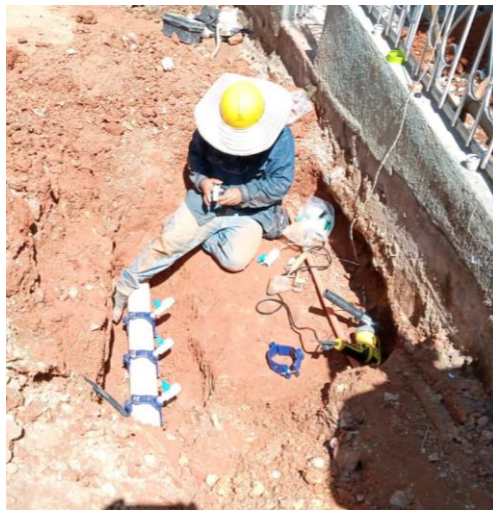
Figura 8. Instalación de collares de derivación.
