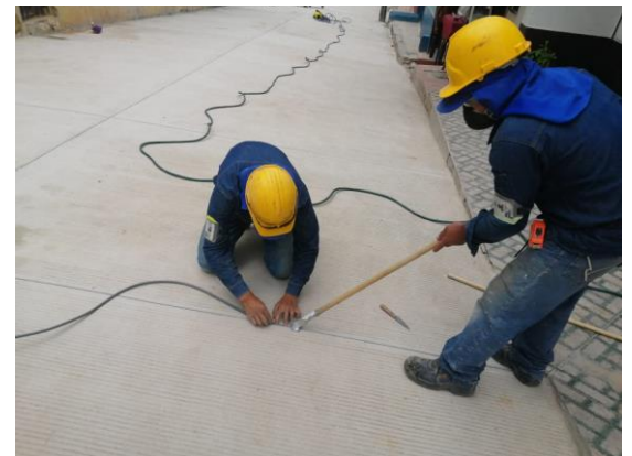
Figura 21. instalación de la cola de ratón para las dilataciones.
