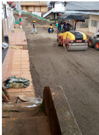
Figura 14. Compactación de la base.
