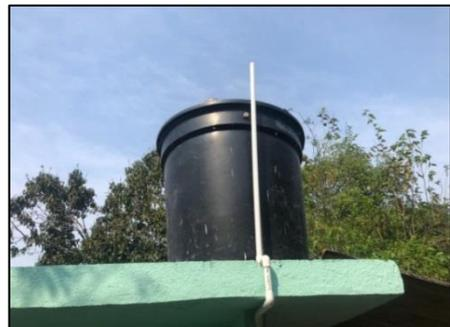
*Fotografía 13.* Suministro e instalación tanque de almacenamiento de 500 lts.
