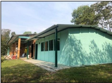
*Fotografía 8.* Pintura koraza para muros exteriores.
