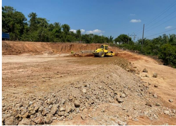
Fotografía 7. Rellenos compensados. Fuente: [Propia.]
