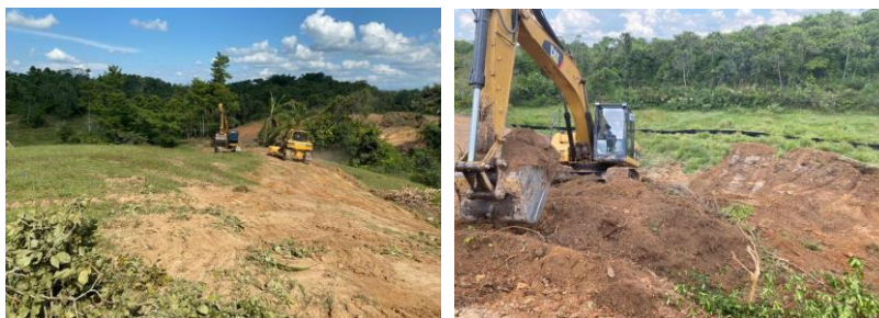
Fotografía 4. Descapote del área de construcción. Fuente: [Propia.]
