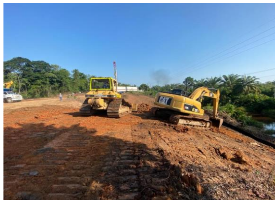
Fotografía 6. Excavaciones. Fuente: [Propia.]
