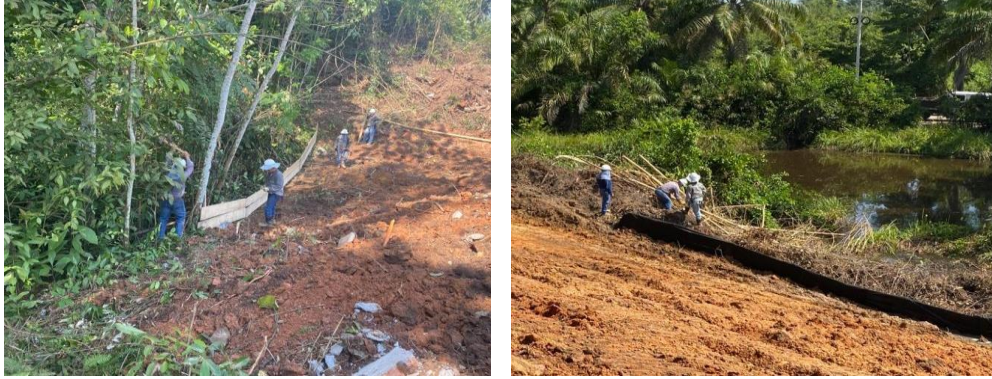
Fotografía 3. Construcción de trinchos de madera. Fuente: [Propia.]
