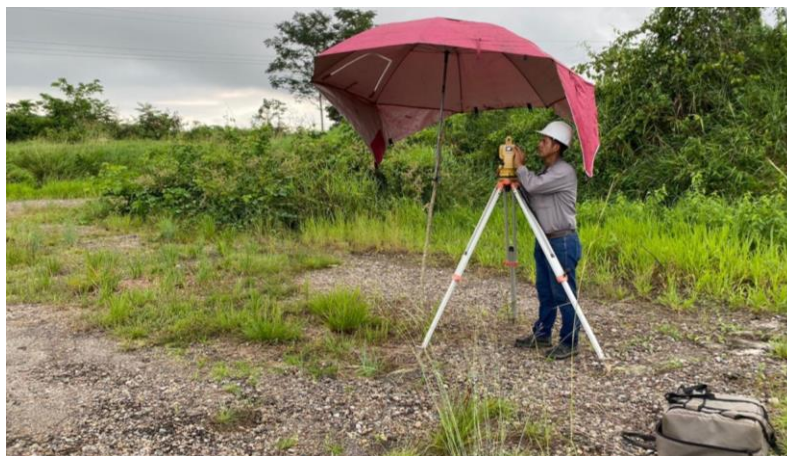
Fotografía 1. Equipo topográfico realizando localización y replanteo. Fuente: [Propia.]
