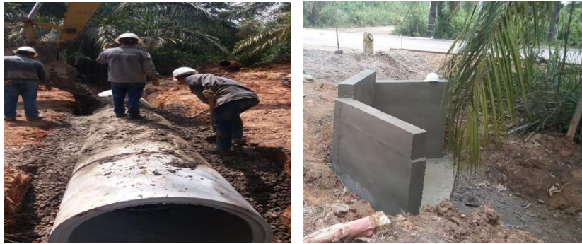
Fotografía 8. Construcción de la alcantarilla. Fuente: [Propia.]
