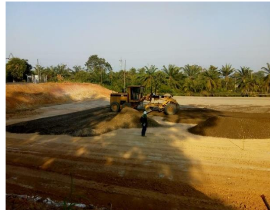
Fotografía 9. Subbase granular. Fuente: [Propia.]
