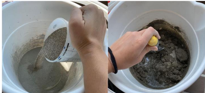
Figura 6. Proceso de combinación de componentes secos y posteriormente con agua. Fotografía de los autores
