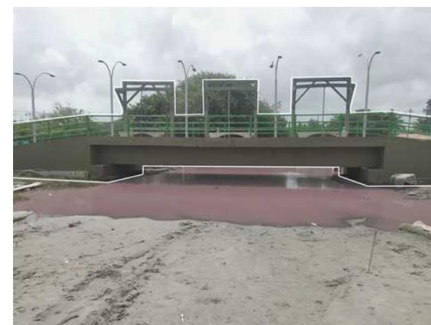
5. Puente cruzando el río rosado
