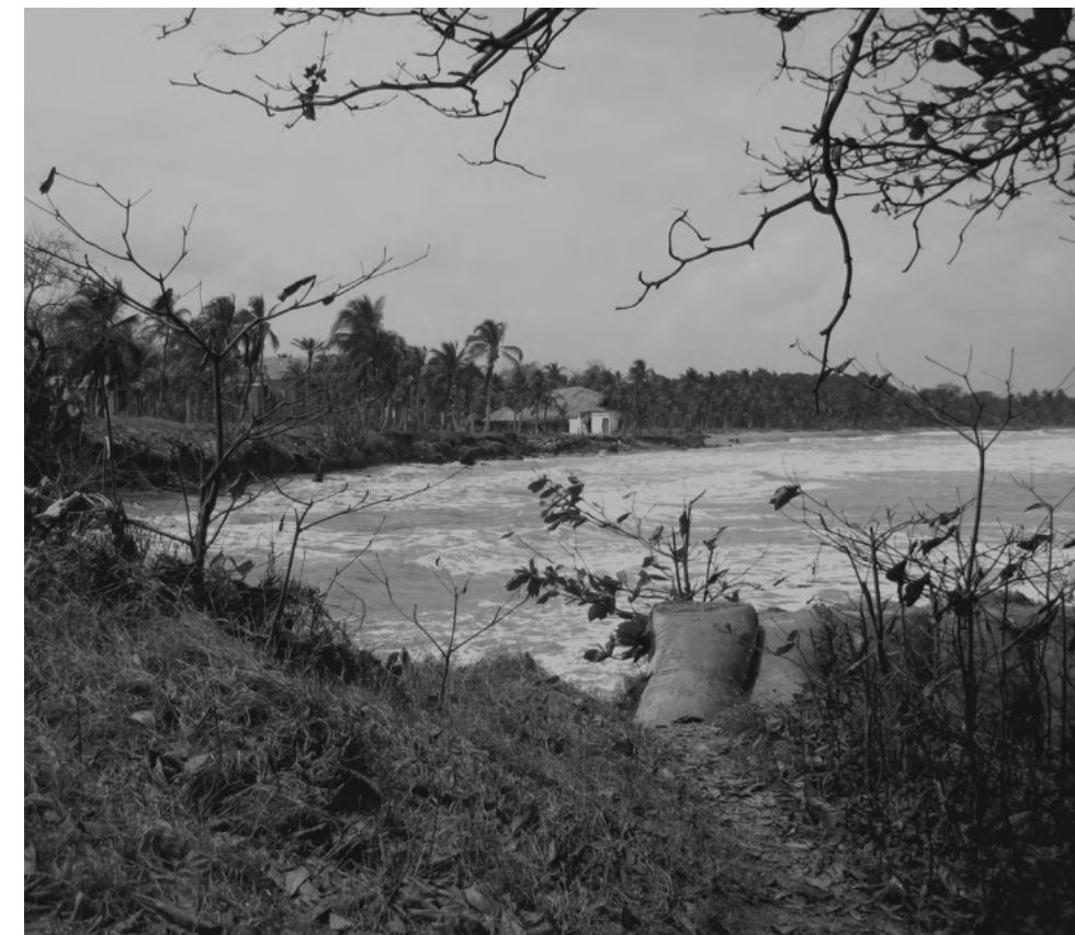
Imagen 1. Costa erosionada de Damaquiel. Fotografía propia. Año 2023 El horizonte de Damaquiel: un paisaje costero erosionado.
