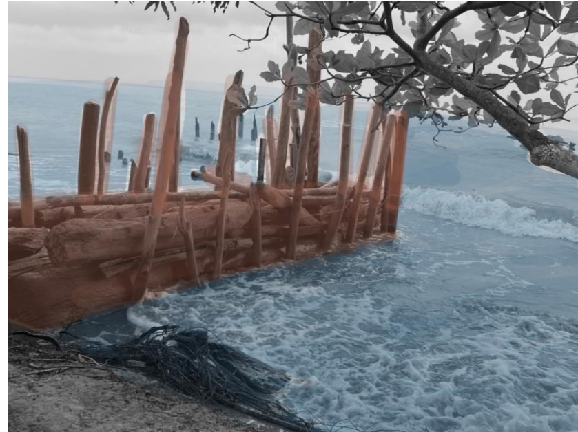
Ilustración 30. Espolones de madera, La Martina, Turbo. Ilustración propia.
