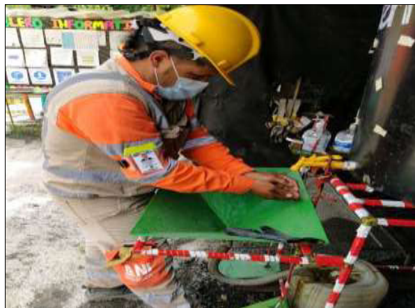
Figura 17. Protocolos covid-19 implementados en obra: lavado y desinfección de manos.
