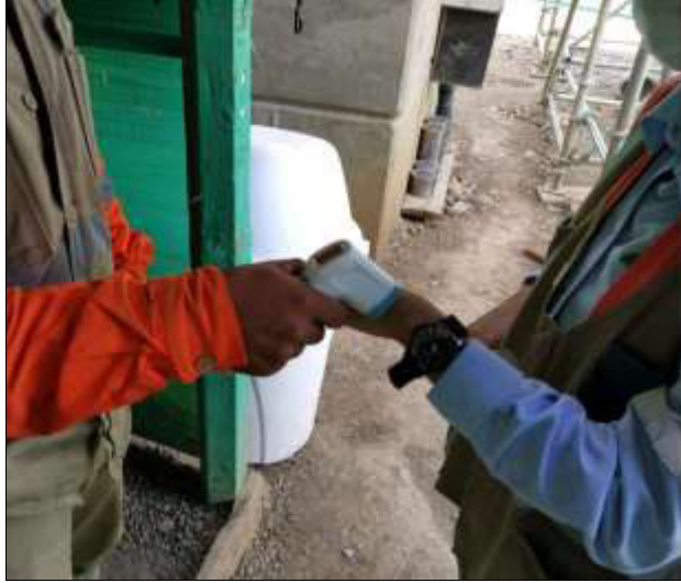
Figura 18. Protocolos covid-19 implementados en obra: toma de temperatura ingreso y salida.
