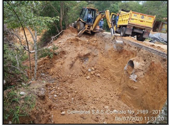
Excavación y explanación del terreno, teniendo en cuenta las cotas de nivel.
