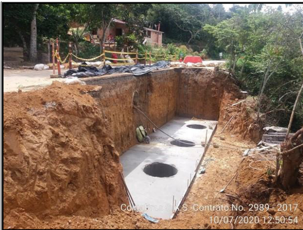
Construcción de Caisson en concreto reforzado profundidades 5m.
