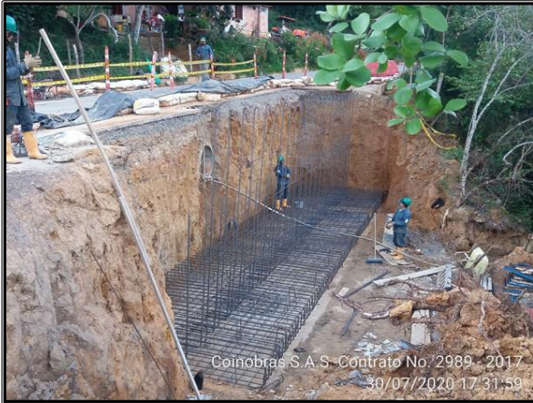
Figurado de acero de zapata y vástago del muro de contención
