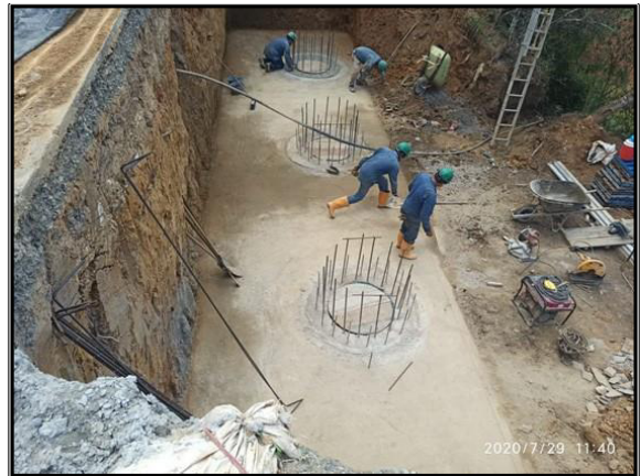
Limpieza del sector para armado zapata y vástago.
