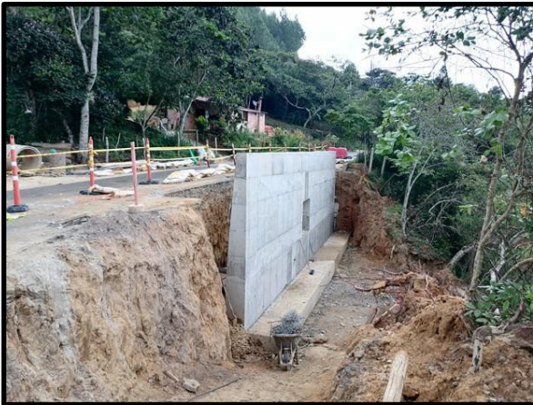
Muro de contención en concreto reforzado
