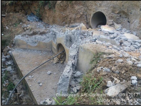
Demolición de estructura existente (Alcantarilla en concreto reforzado de 36")
