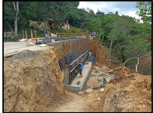
Instalación de formaleta para vástago de muro de contención.
