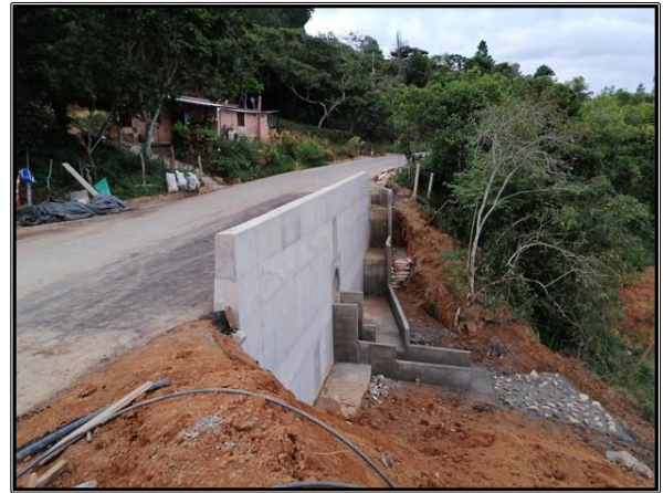
Relleno y construcción de disipador de muro de contención
