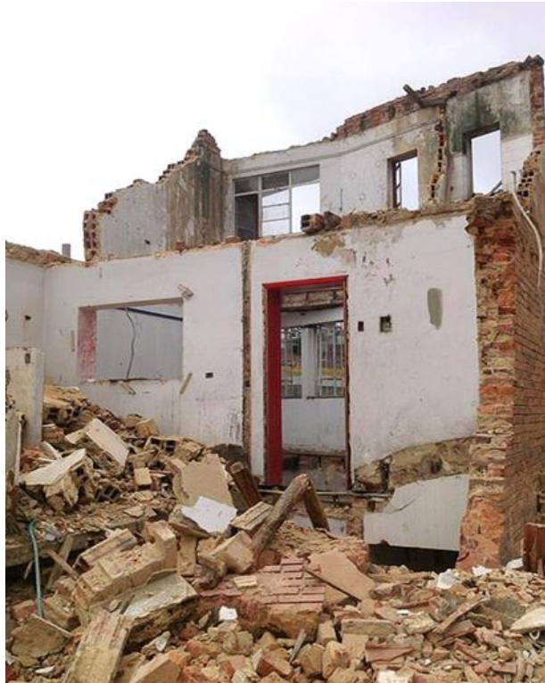
Ilustración 4. Demolición de la estructura existente
