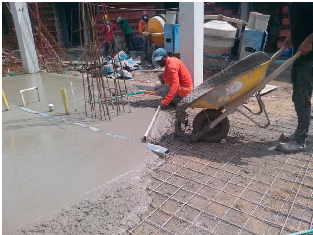
Ilustración 10. Vaciado de concreto para placa sólida
