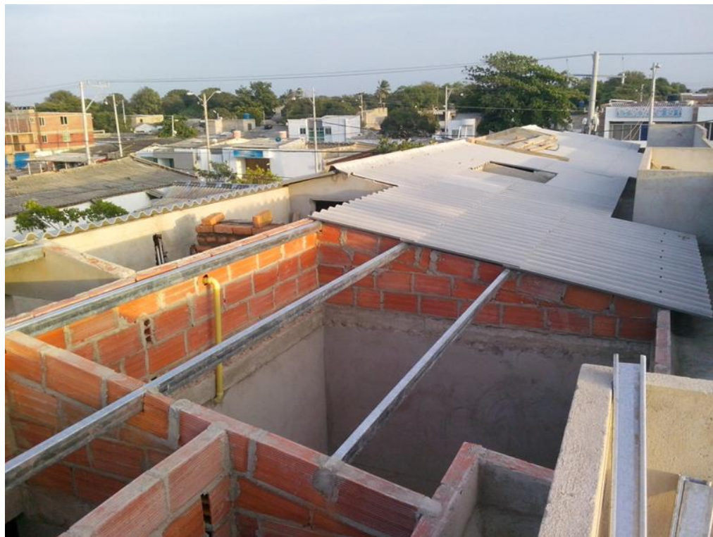
Ilustración 22. Instalación de tejas de Eternit para cubierta
