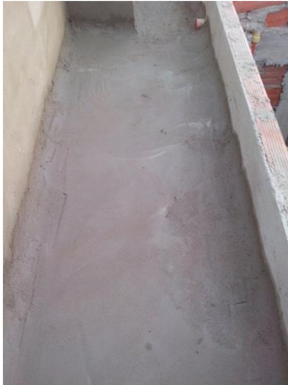
Ilustración 23. Viga canal para desagüe de aguas lluvia
