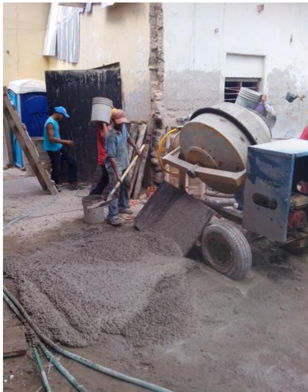
Ilustración 14. Realización de la mezcla de concreto
