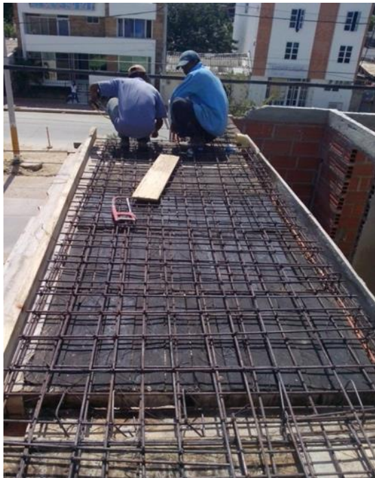
Ilustración 17. Armado de acero para placa de entresiso Fuente: Autor del proyecto
