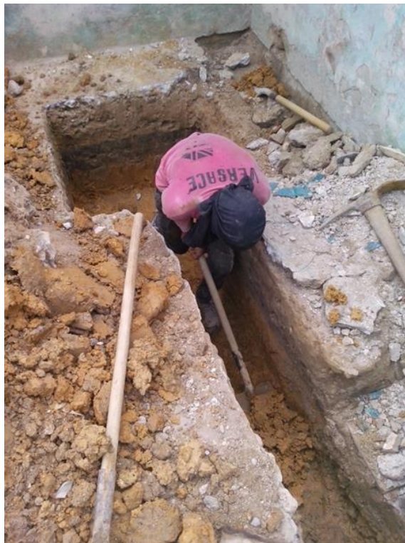
Ilustración 5. Excavación y retiro de material común Fuente: Autor del proyecto
