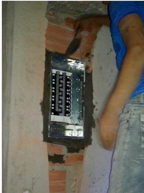
Ilustración 25. Instalación de tablero de circuitos eléctricos Fuente: Autor del proyecto
