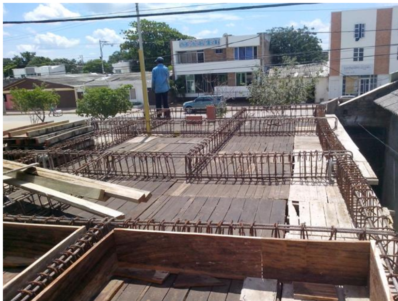
Ilustración 15. Armado de acero para vigas de entrepiso
