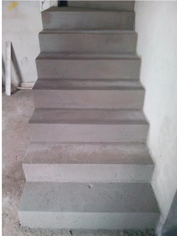
Ilustración 19. Acabado de escalera en concreto reforzado Fuente: Autor del proyecto
