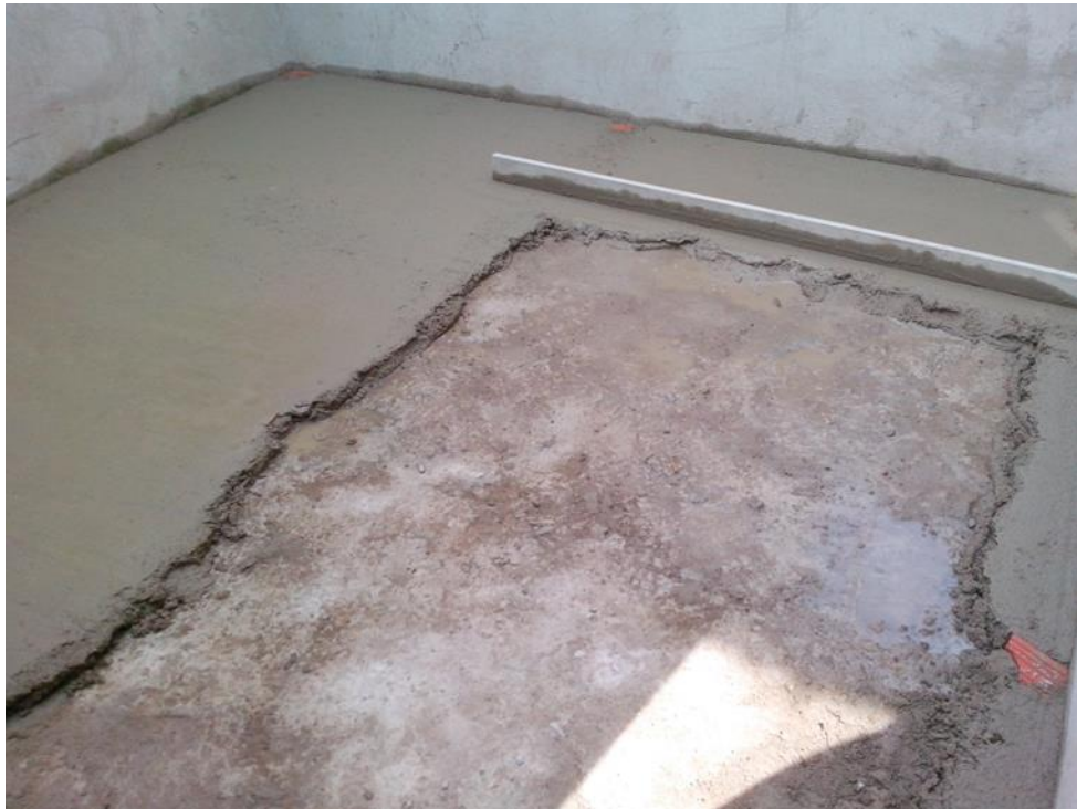
Ilustración 20. Vaciado de plantilla para nivelar la placa
