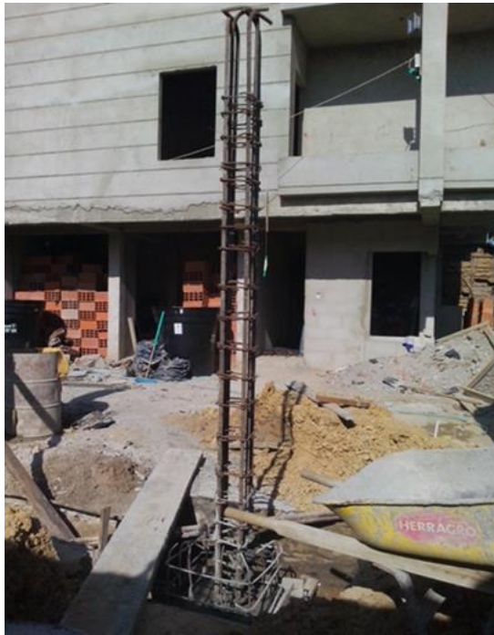
Ilustración 16. Armado de acero para columnas Fuente: Autor del proyecto
