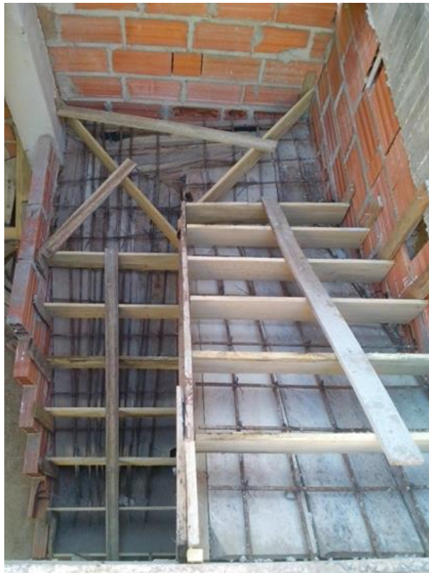
Ilustración 18. Armado de acero y encofrado de escalera
