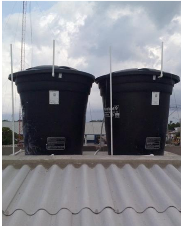
Ilustración 28. Instalación de tanque elevado Fuente: Autor del proyecto
