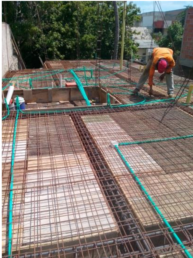
Ilustración 24. Instalación de tubería eléctrica en 2do Piso Fuente: Autor del proyecto
