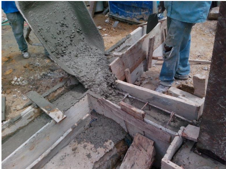
Ilustración 8. Fundida de vigas de amarre para cimentación Fuente: Autor del proyecto
