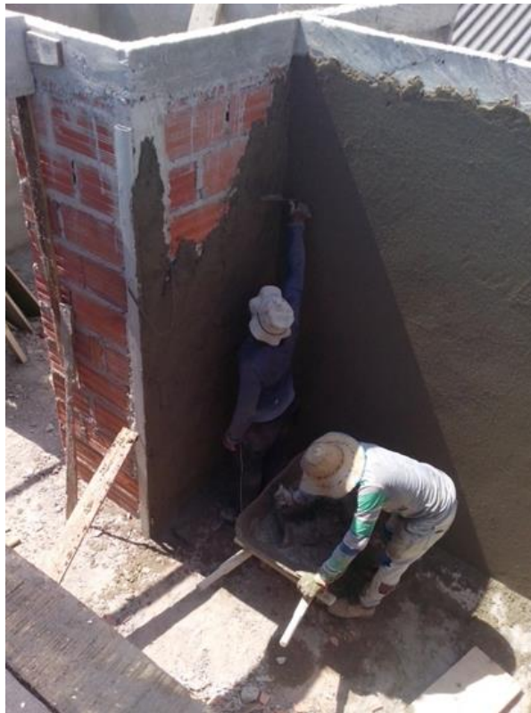
Ilustración 21. Pañetado liso de muro en interior Fuente: Autor del proyecto
