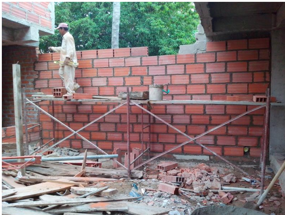
Ilustración 12. Mampostería en ladrillo hueco de arcilla
