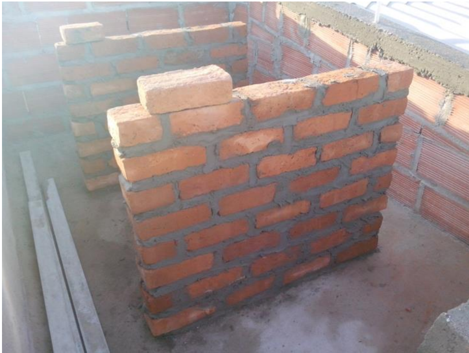
Ilustración 13. Mampostería en ladrillo prensado
