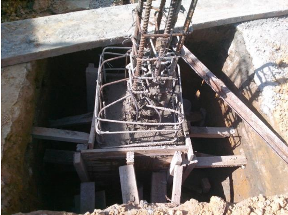
Ilustración 7. Fundida de zapata y pedestal para cimentación Fuente: Autor del proyecto
