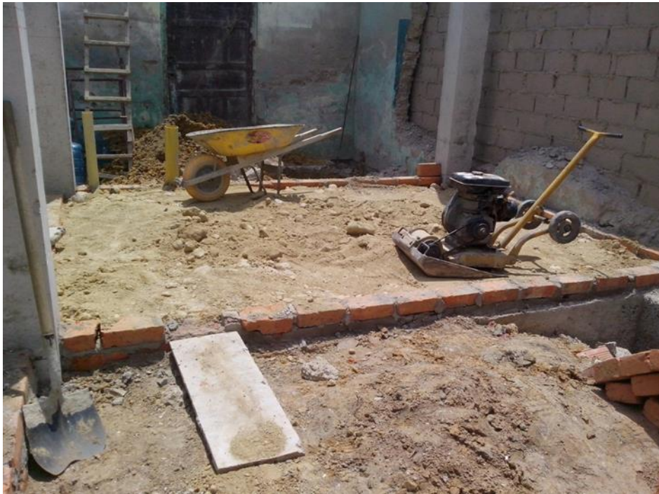
Ilustración 6. Relleno y compactación de material común
