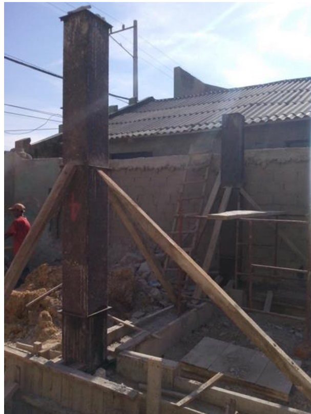
Ilustración 9. Fundida de columnas en concreto Fuente: Autor del proyecto
