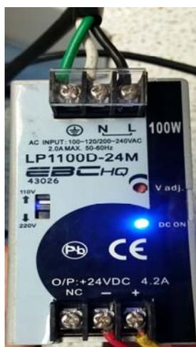
**Figura 22. Conexión fuente de alimentación de 24 VDC**
