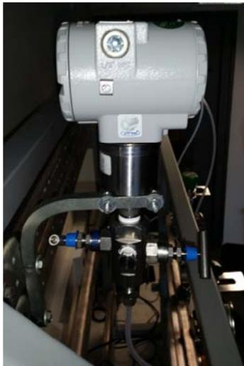
Figura 18. Fijación del transmisor a la toma de proceso
