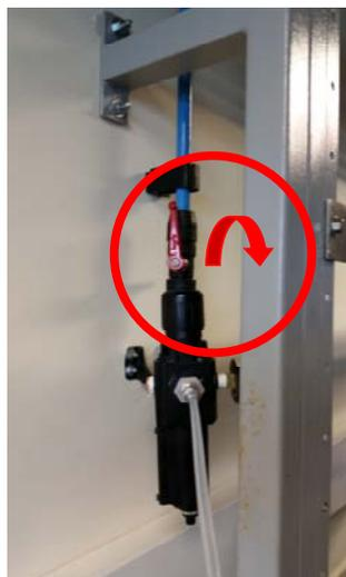
**Figura 12. Válvula tipo bola en posición abierta, girar 90° para cerrar.**
