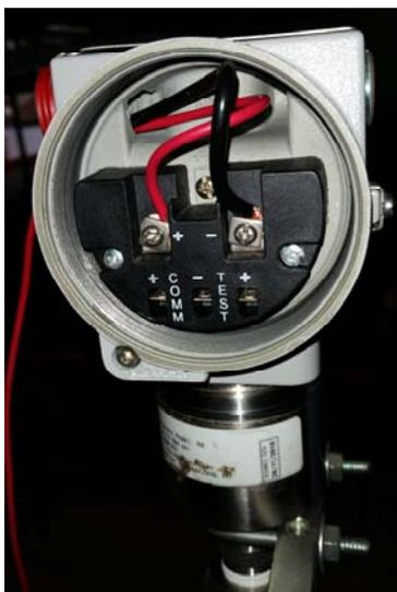
**Figura 21. Conexión transmisor indicador de presión SMAR 4 a 20 mA**
