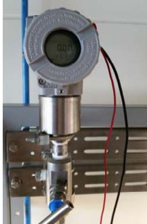
**Figura 9. Transmisor indicador de presión SMAR 4 a 20mA**
