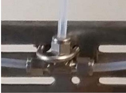
Figura 17. tee con conexión rápida
