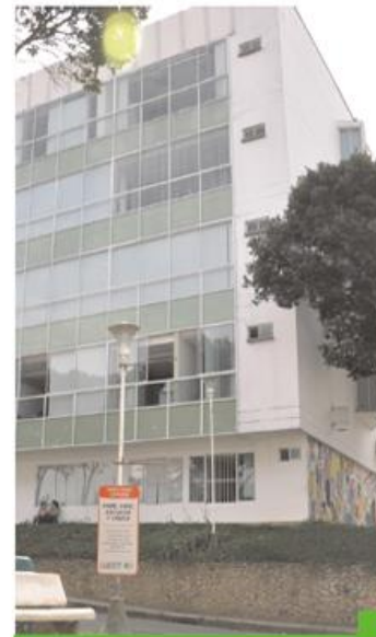
Edificio Administración II. Vicerrectoría de Investigación y Extensión. Campus Central UIS.
