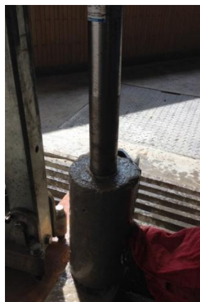
Figura 19 Extracción de núcleos
