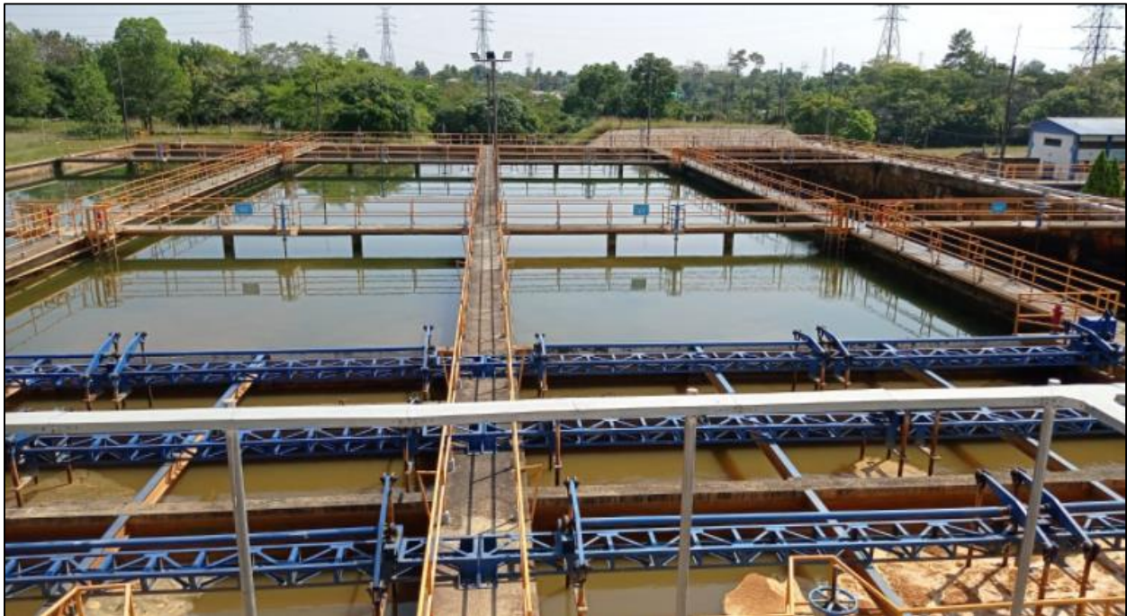
Fig 5 Sistema sedimentación y floculación
