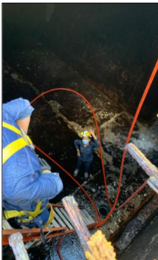
Fig 34 Parada de planta para lavado de tanques de almacenamiento
