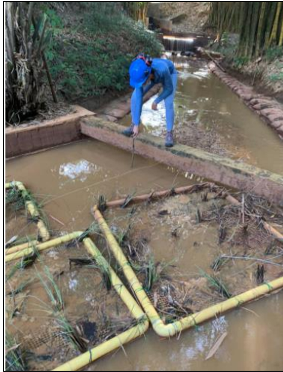
Fig 11 Inspección zona de lodos
