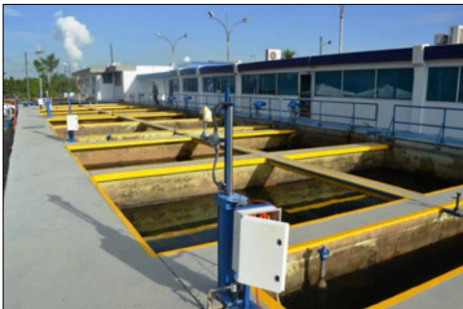
Fig 8 Galería de filtros
