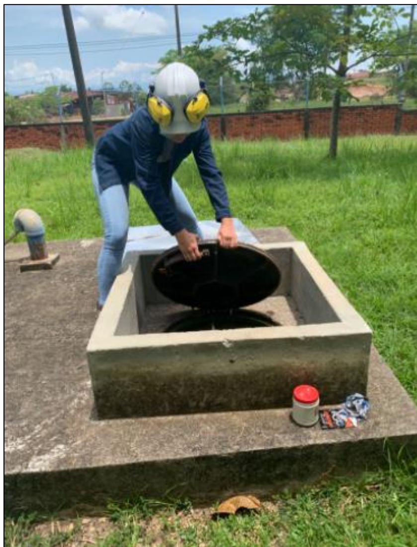
Fig 10 Inspección de macromedidor de entrada en la línea de 30 pulgadas
