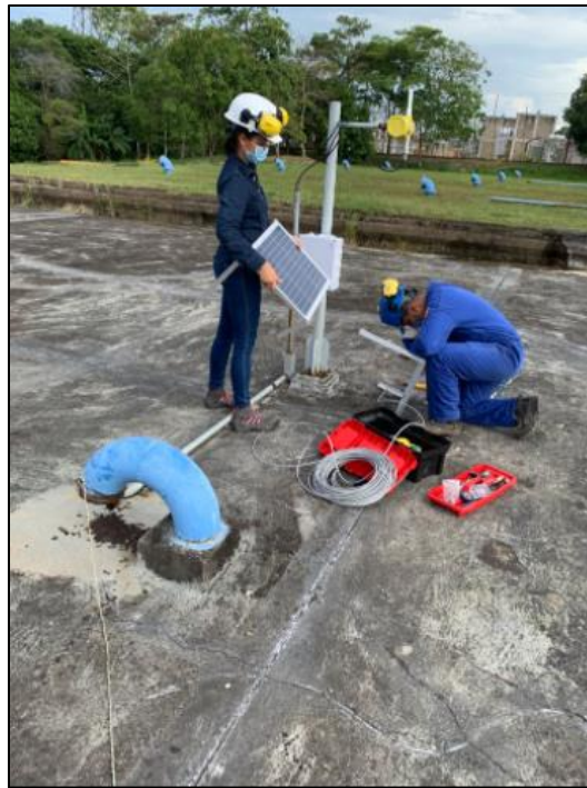
Fig 12 Inspección de sistema fotovoltaico para la autosuficiencia de los sensores de nivel de los tanques de almacenamiento
