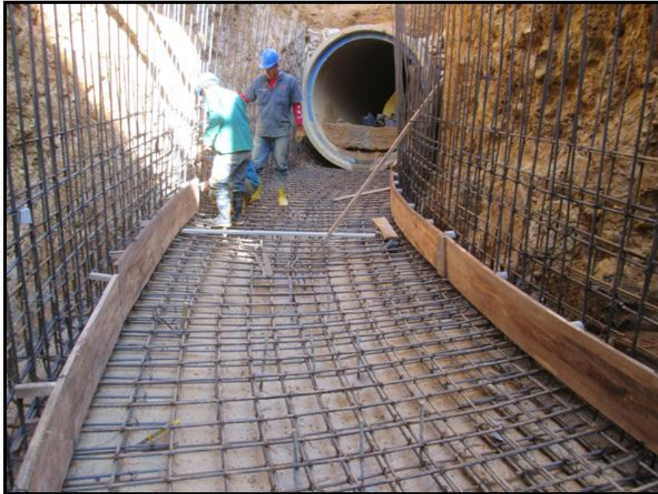
Figura # 18. Refuerzo para la estructura
