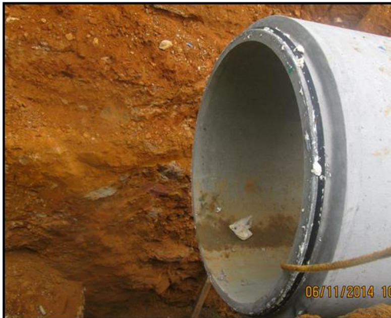
Figura # 7. Instalación de tubería con ayuda de maquinaria.
