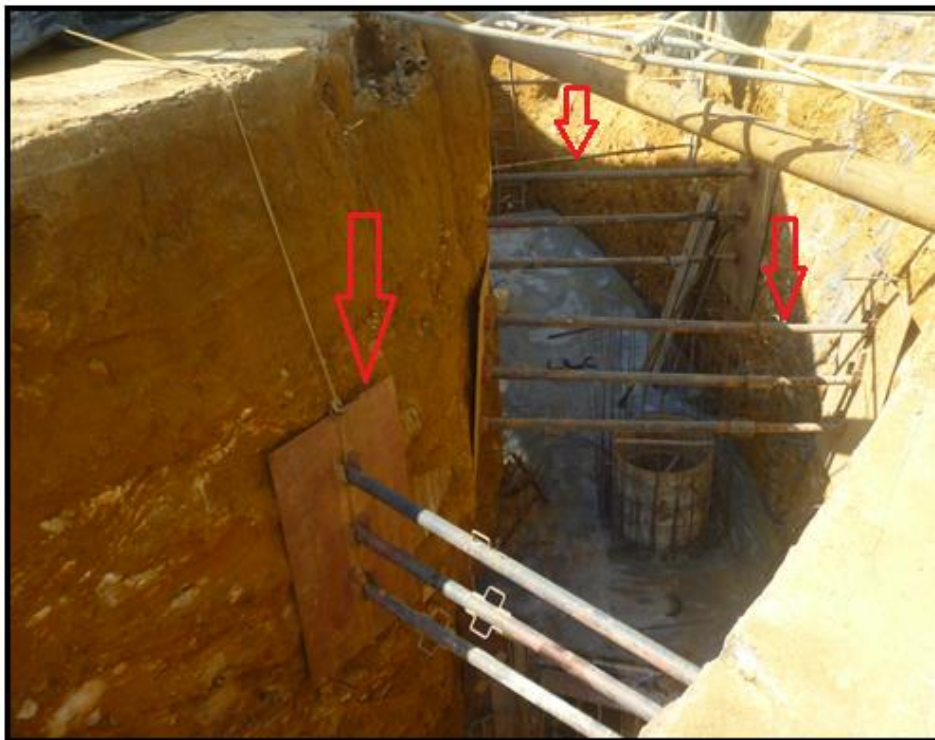
Figura # 5. Tablestaca para la estabilización del terreno.
