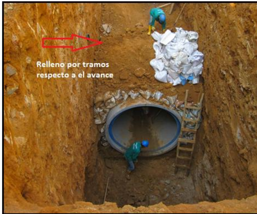
Figura # 4. Relleno por tamos, respecto al avance.
