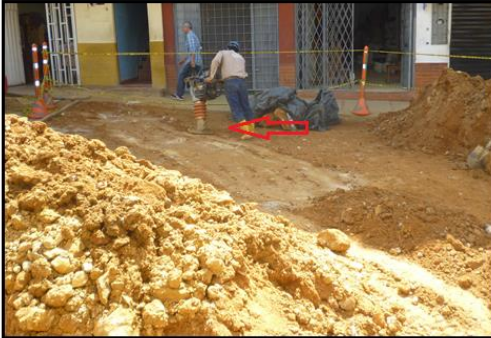
Figura # 11. Máquina para compactar el suelo
