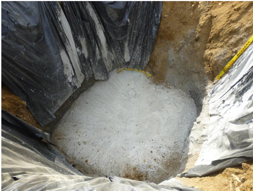
Figura # 28. Concreto ciclópeo para zapatas
