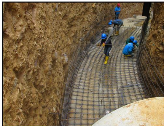
Figura # 17. Refuerzo para la estructura
