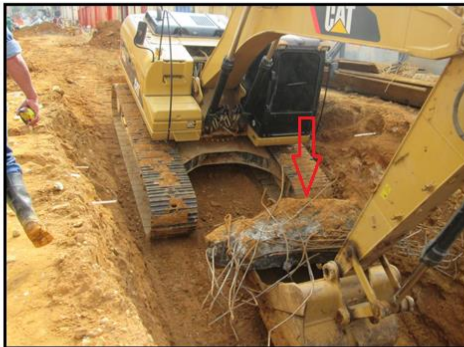
Figura # 21. Muro de concreto reforzado demolido.
