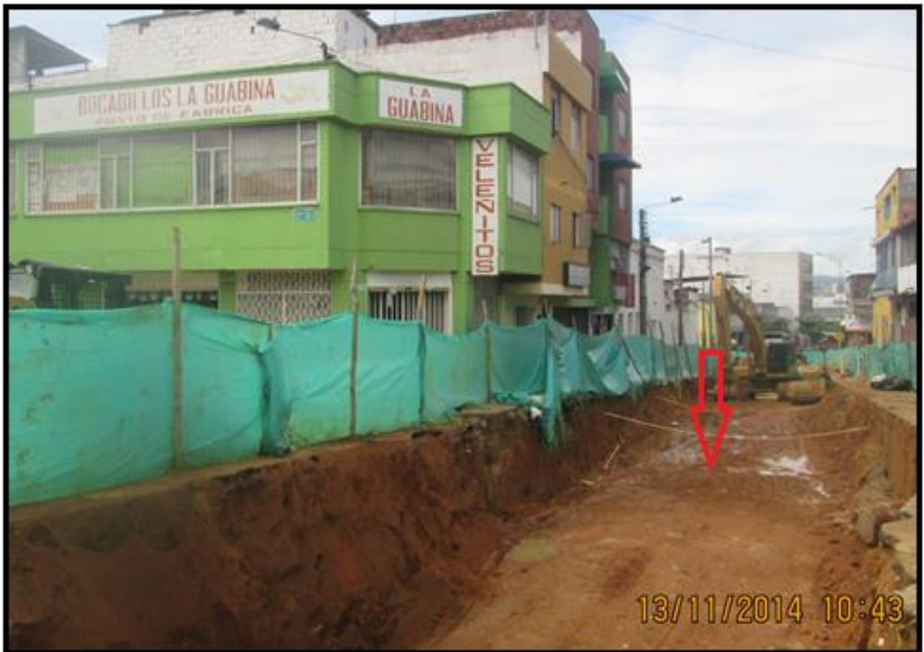
Figura # 10. Relleno de acuerdo al avance de la tubería.
