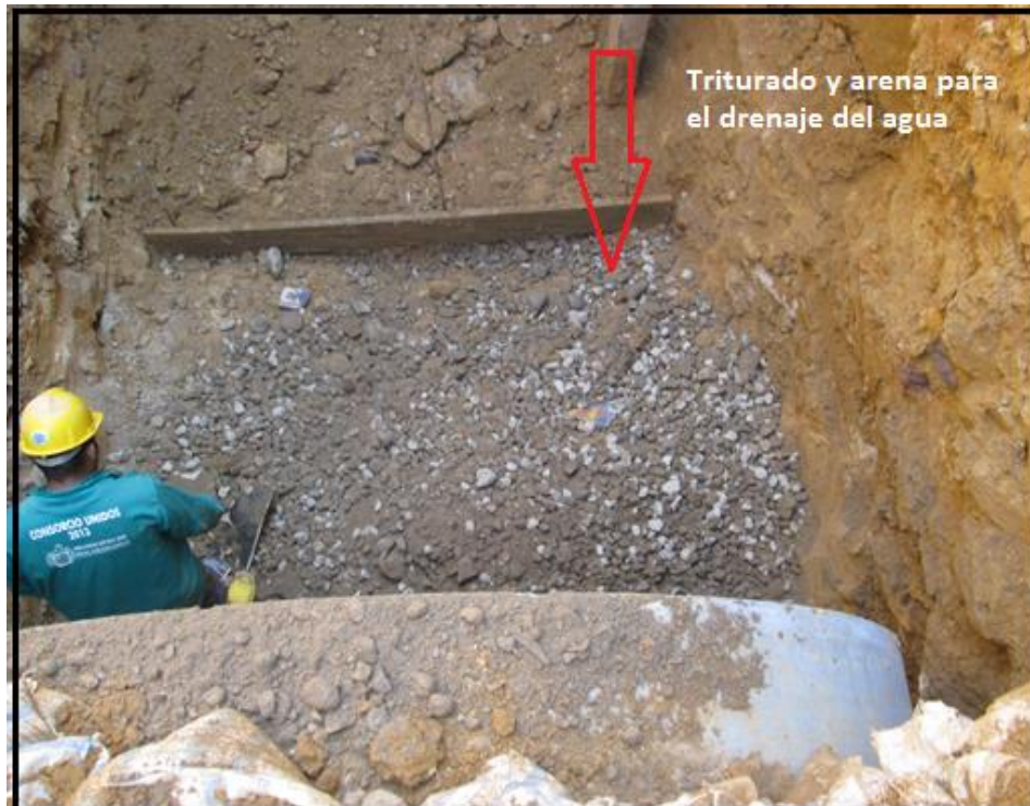
Figura # 2. Excavación para cambio de tubería.
