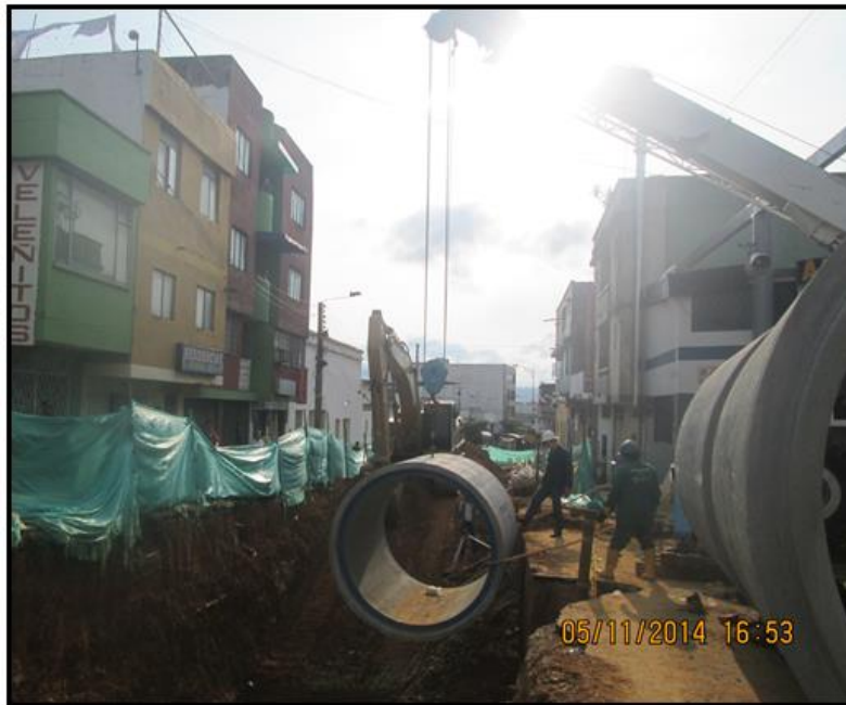
Figura # 7. Instalación de tubería con ayuda de maquinaria.
