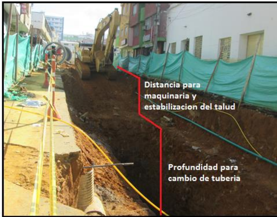
Figura # 2. Excavación para cambio de tubería.
