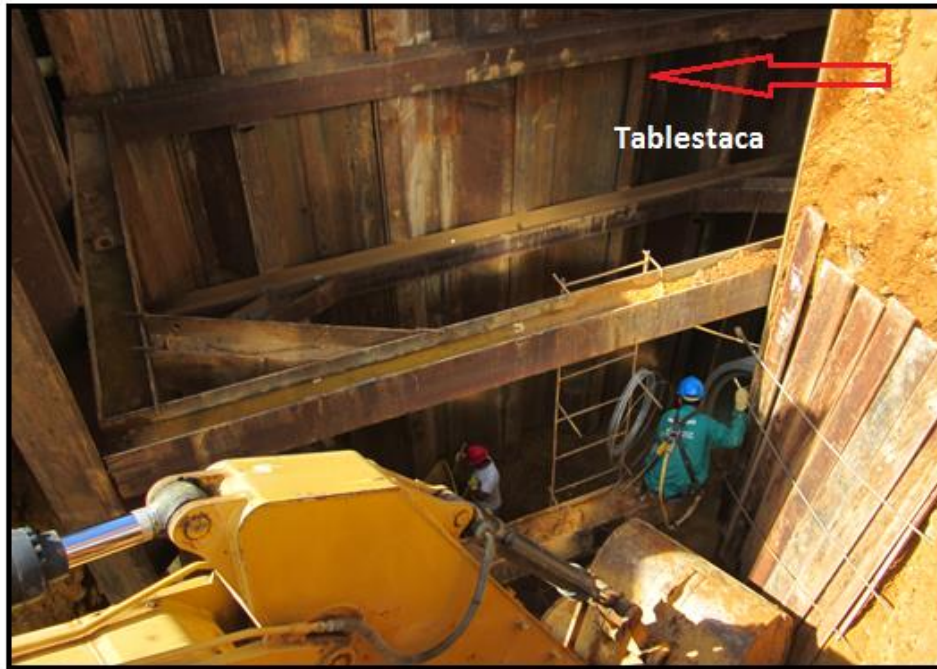
Figura # 5. Tablestaca para la estabilización del terreno.
