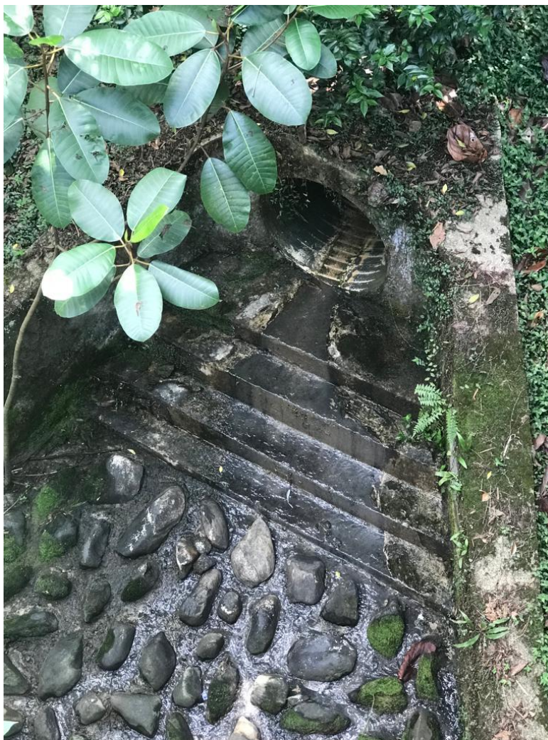
15Foto: Desagüe parte baja del Parque Comercial 75
