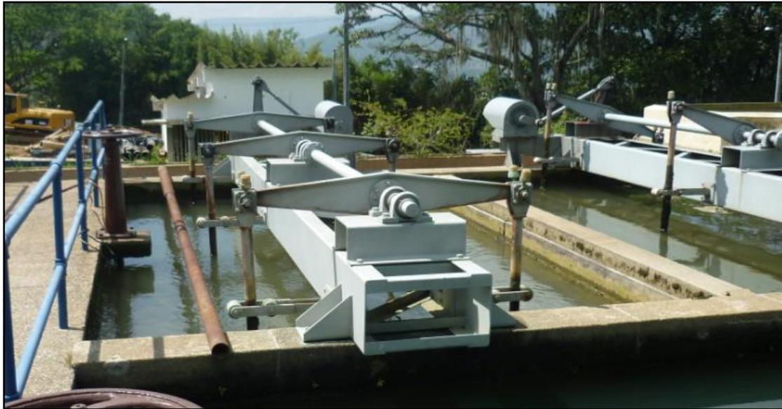
**Figura 2. Floculador mecánico de balancín reciprocante. Sección 1 de la planta**
