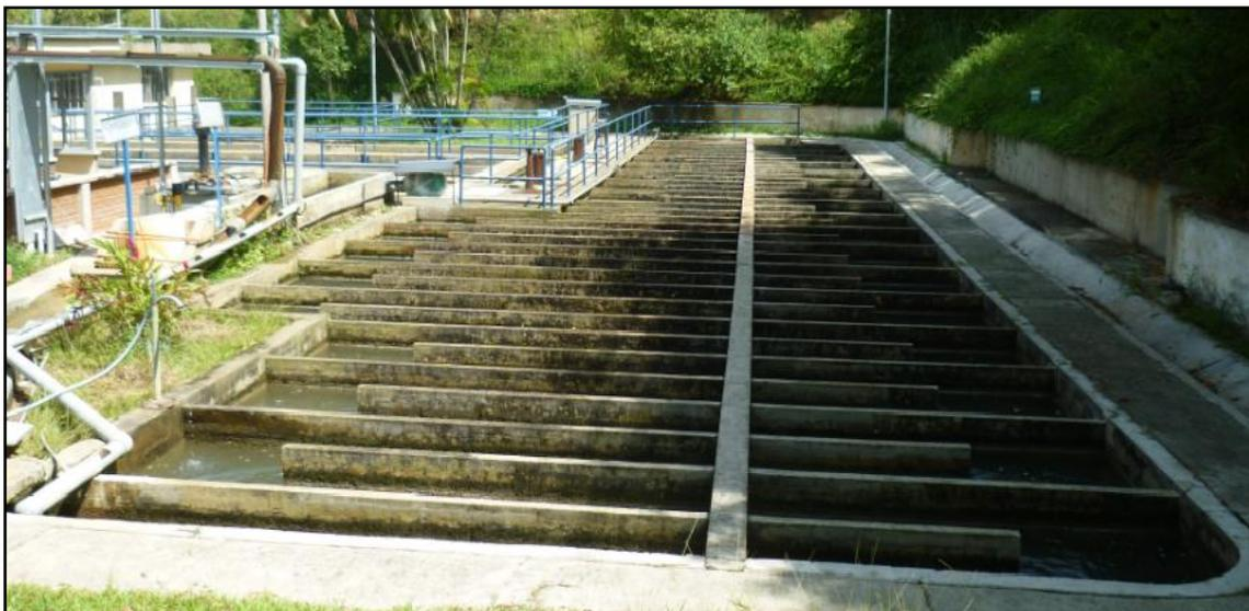
**Figura 3. Floculador hidráulico de flujo horizontal. Sección 2 de la planta.**
