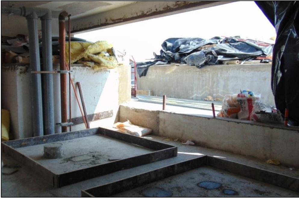
Imagen 6. Estructura puertos de calderos, Pre – instalación; Edificio Roble III
