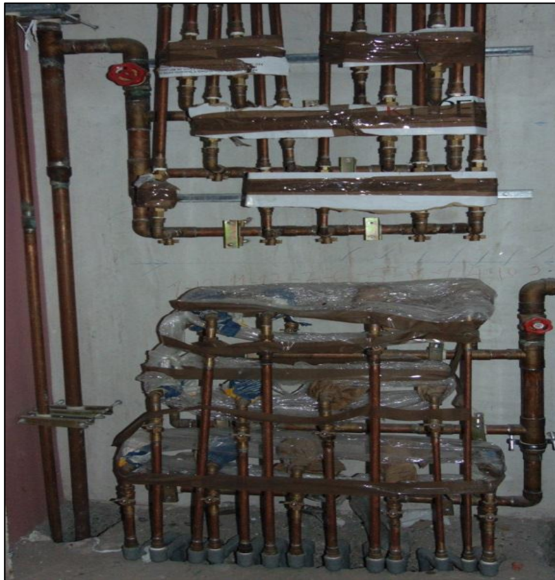
Imagen 5. Manifold instalados, Red agua potable (Fría y Caliente); Edificio Tineo I & IV
