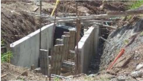
Imagen 53 Encofrado canal perimetral con deflectores
