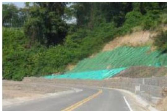
Imagen 25 Talud con muro en gaviones
