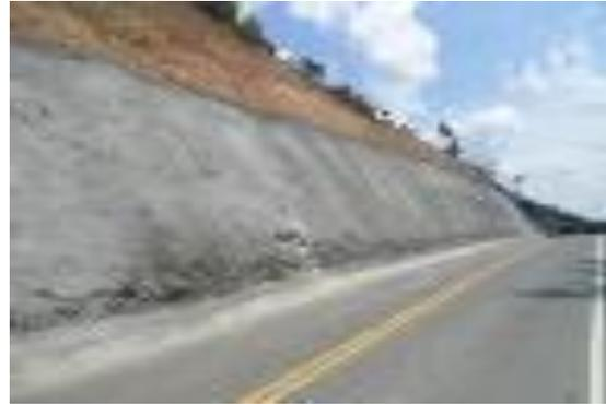
Imagen 10 Talud estabilizado con concreto lanzado
