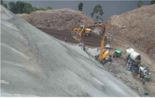
Imagen 29 Concreto lanzado
