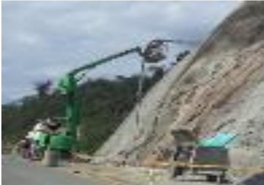
Imagen 8 Lanzado de concreto
