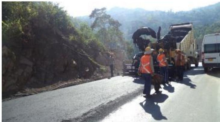
Imagen 65 Colocación estructura de pavimento
