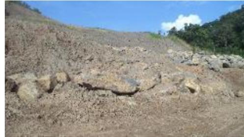
Imagen 54 Conformación de enrocado
