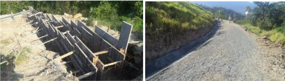
Imagen 62 Amarre de acero de refuerzo para estructura de disipación N° 2 entre cunetas berma y canal disipador
