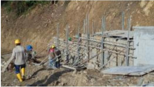
Imagen 50 Encofrado módulo canal dissipador
