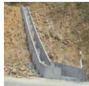
Imagen 32 Armado de acero, instalación de formaleta y vaciado de concreto para estructura de disipación
