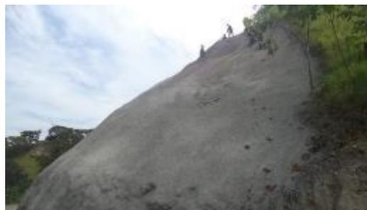
Imagen 33 Concreto neumático
