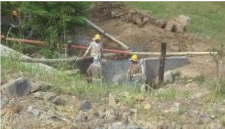
Imagen 58 Vaciado estructura de salida
