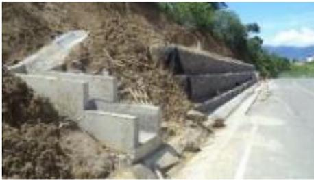
Imagen 22 Construcción e estructura de salida
