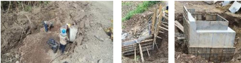
Imagen 34 Instalación del tubo, armado de refuerzo para estructura de entrada y salida, vaciado de concreto.
