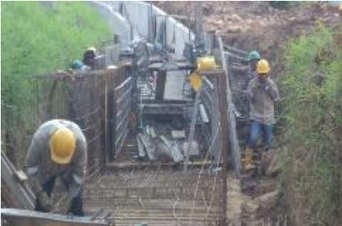
Imagen 55 Encofrado Canal Disipador con deflectores
