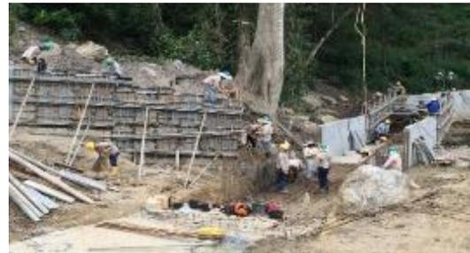
Imagen 61 Conexión Box Culvert y alcantarilla con el canal interceptor
