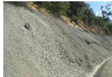
Imagen 18 Talud terminado con concreto lanzado
