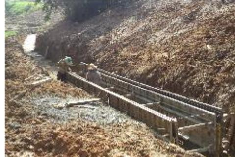
Imagen 56 Armado de acero Canal Interceptor
