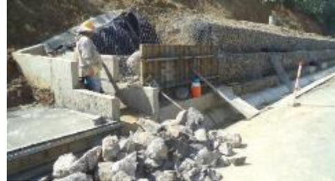
Imagen 23 Conformación muro en gaviones
