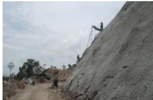
Imagen 11 Perforación de drenes 20 m de longitud – K2+500, MB
