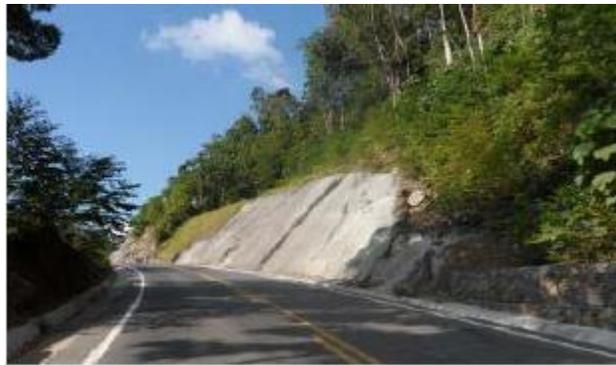
Imagen 16 Talud con concreto lanzado
