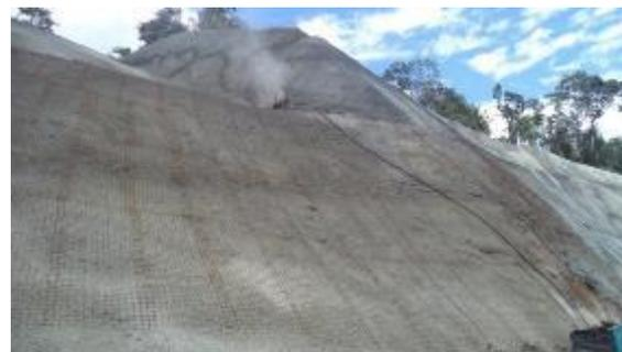
Imagen 28 Instalación de malla electrosoldada y perforación de pernos
