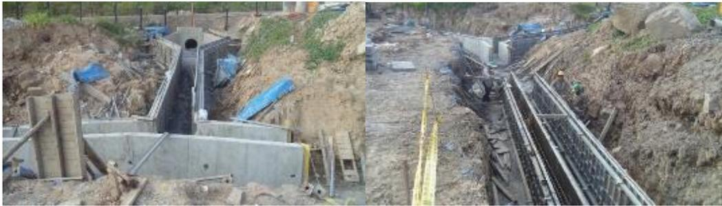
Imagen 63 Vaciado de concreto para muros de aproximación y estructura de entrada
