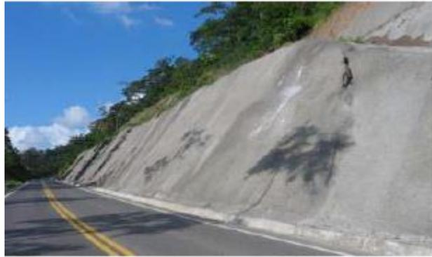
Imagen 15 Concreto lanzado y 10% de biomanto
