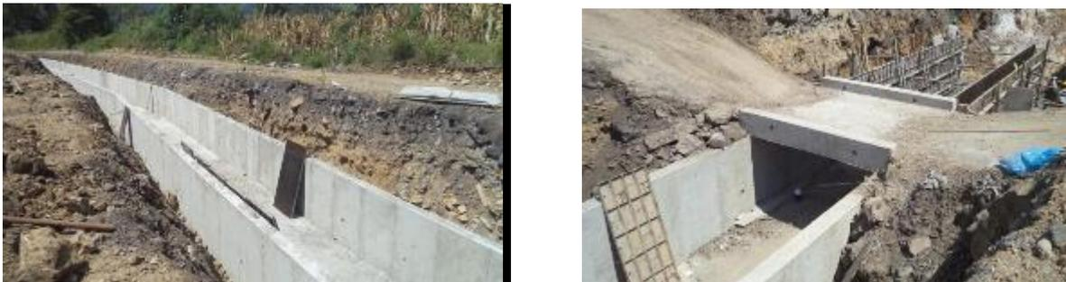
Imagen 57 Construcción canal interceptor tipo 7
