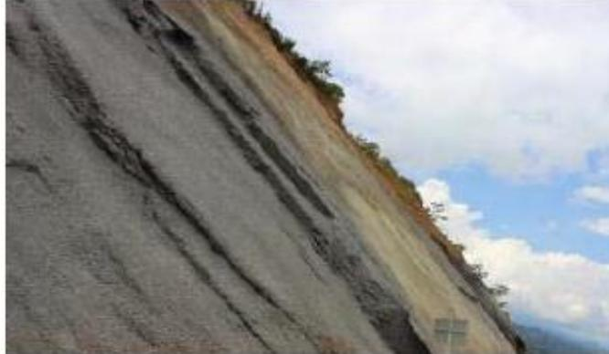
Imagen 19 Talud perfilado y con concreto lanzado
