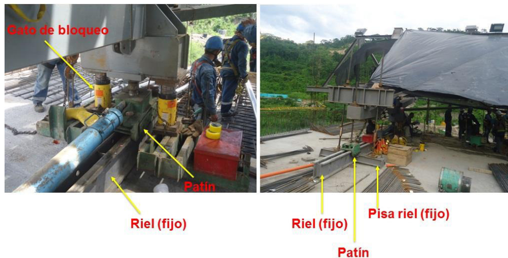
IMAGEN 24. BLOQUEO DEL CARRO DE AVANCE
