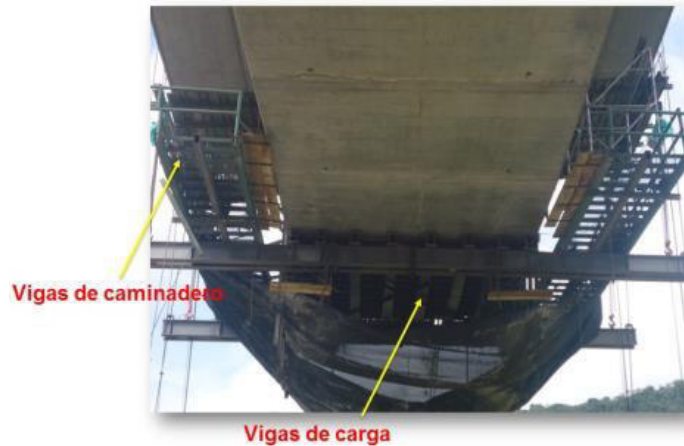
IMAGEN 9. VISTA INFERIOR DEL CARRO DE AVANCE
