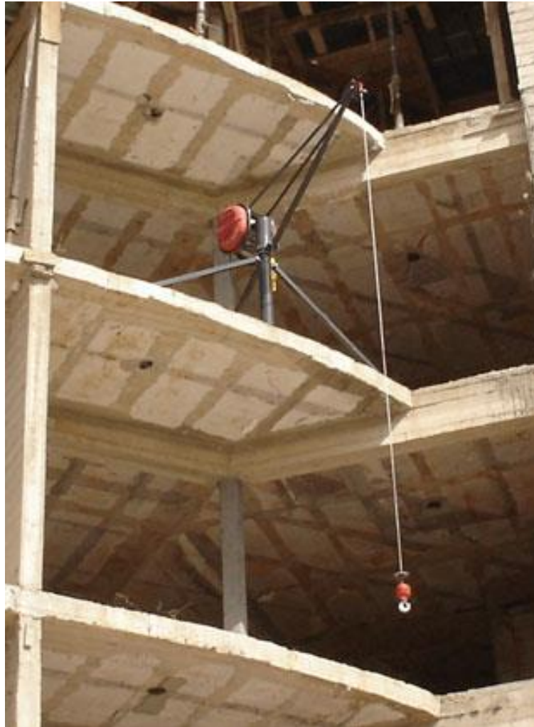
Imagen 9. Ejemplo de equipo Elevadores tipo malacate.
