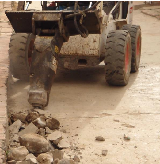
Figura 24 Demolición concreto
