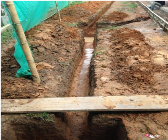
Figura 19 Excavación de las cajas y desagüe
