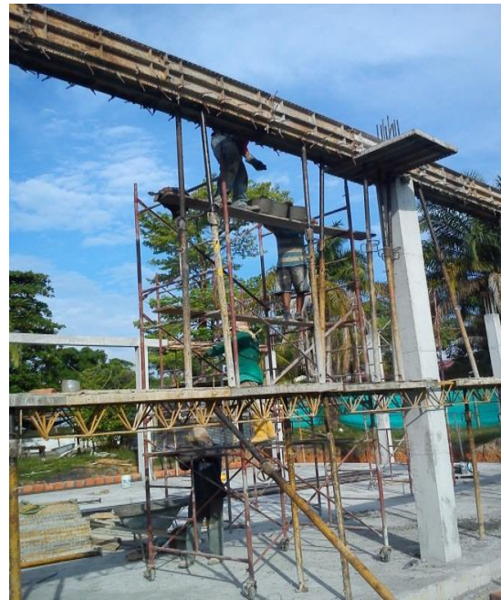
Figura 9 Fundida de vigas aéreas
