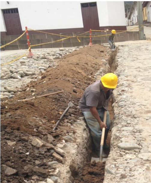
Figura 27 Excavación manual
