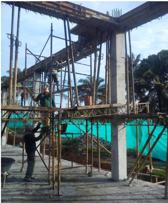
Figura 8 Formaleta metálica vigas aéreas
