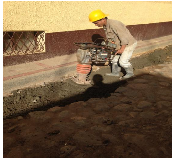
Figura 60 Compactación de base
