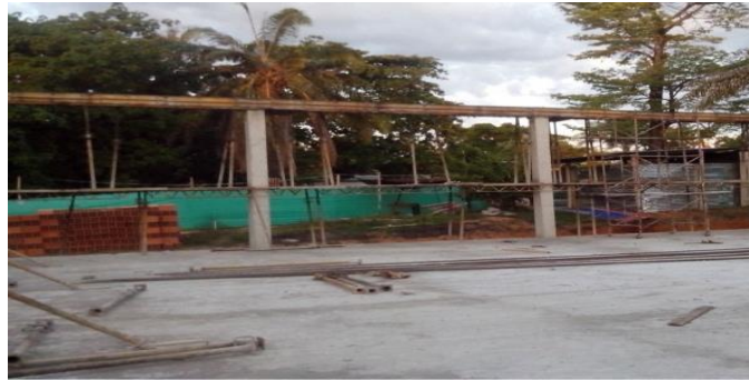
Figura 7 Formaleta metálica vigas aéreas
