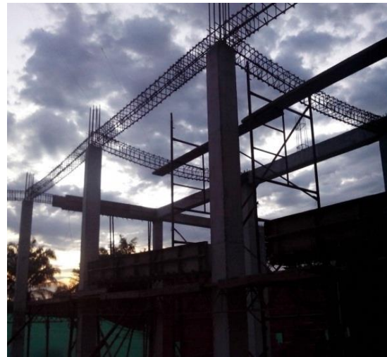
Figura 6 Refuerzo en hierro de vigas centrales
