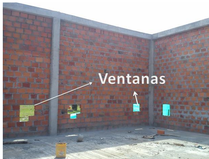
Figura 10 Mampostería con las ventanas
