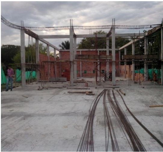
Figura 5 Refuerzo en hierro de vigas
