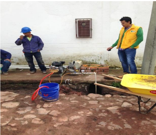
Figura 53. Prueba hidráulica
