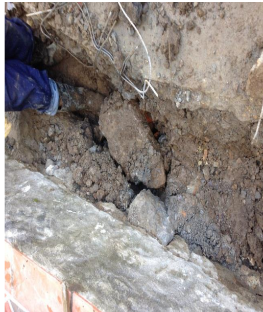
Figura 28 Excavación en roca
