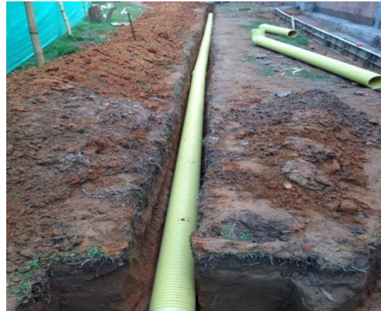
Figura 20 Instalación de la tubería de desagüe
