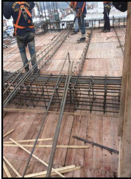
**Figura 11. Armado Vigüeta -VTA 60- in situ**
