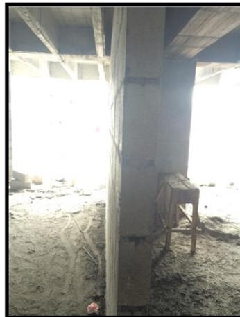
**Figura 18. Muro a plomo**
