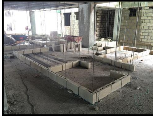
**Figura 17. Replanteo de muros de mampostería H-9**
