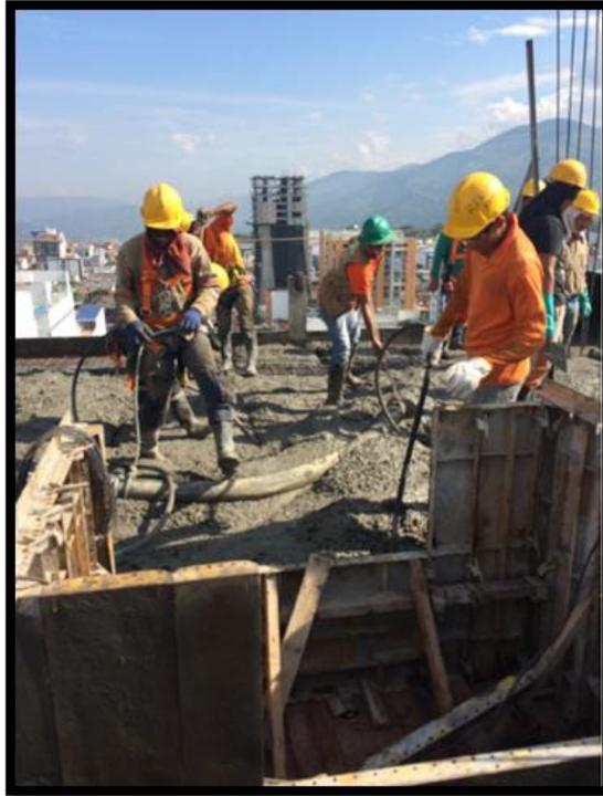
**Figura 15. Vibrado Concreto**
