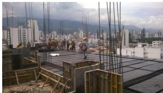
**Figura 13. Instalación casetones Placa Piso 12**
