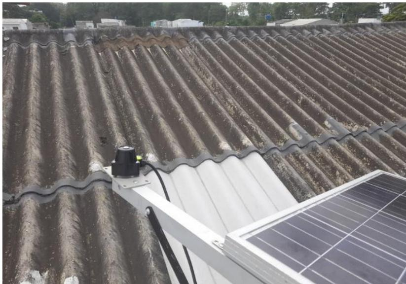
**Figura 19. Sensor de radiación instalado en la estructura. Fuente: Propia**
