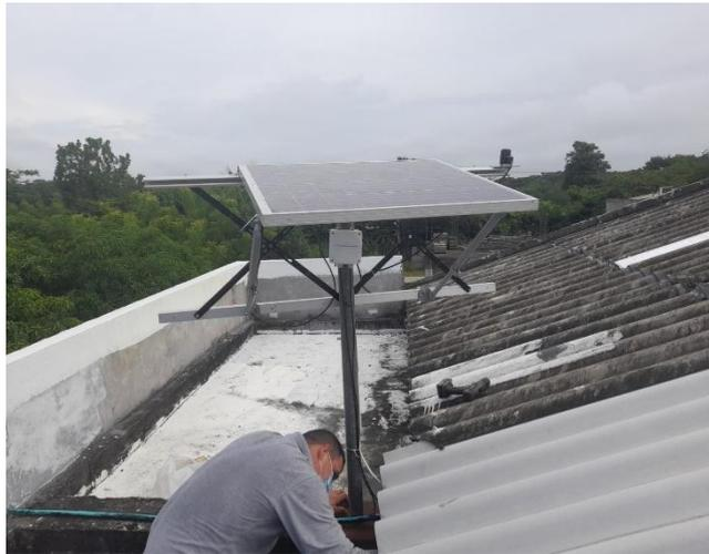
**Figura 10. Soporte para el módulo fotovoltaico Fuente: propia.**
