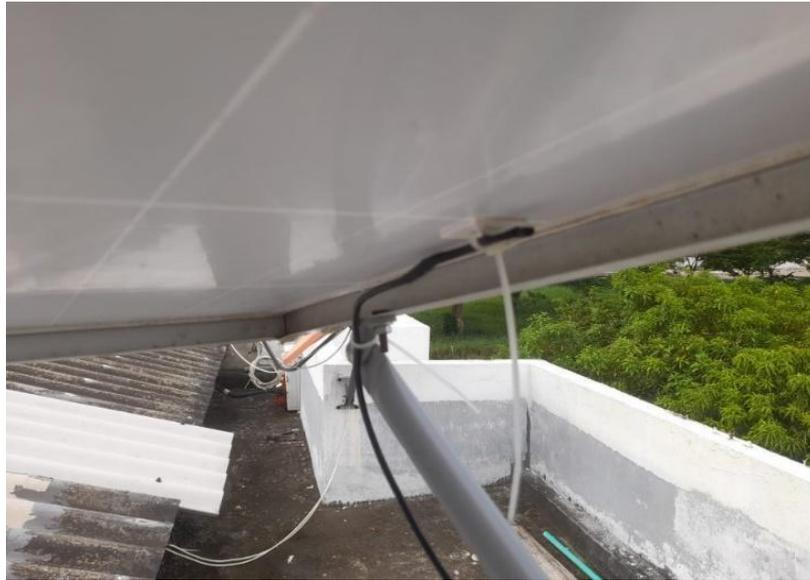
**Figura 18. Sensor de temperatura instalado en la estructura. Fuente: Propia.**
