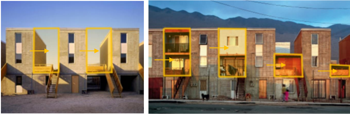
Imagen 8. Proyecto Quinta Monroy, Antes y después de la intervención de los habitantes.
