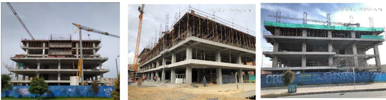
Imagen 1. Adelanto de construcción
