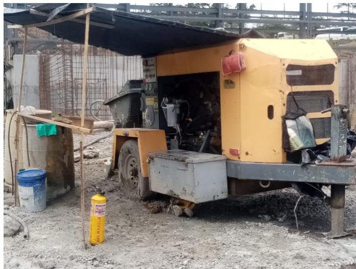
Ilustración 6 Elementos de Seguridad en Obra
