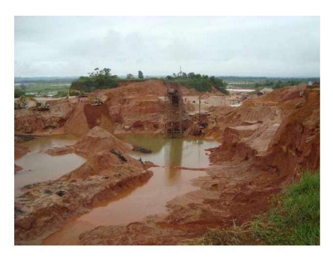
*Nota:* La figura ilustra un frente minero de extracción de oro de aluvión, se puede observar un canalón de clasificación de material, cuatro máquinas pesadas (excavadoras y bulldozer) y el evidente daño al área intervenida. *Fuente:* Elaboración propia.
