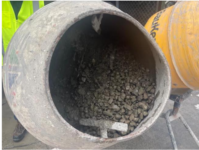
Figura 25 Mezcla de los materiales en el trompo
