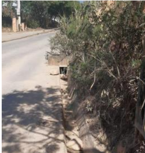
Figura 10 Mantenimiento de las estructuras para evacuación de aguas
