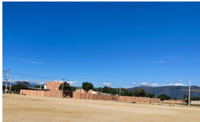
Figura 7 Cerramiento perimetral en los alrededores del predio
