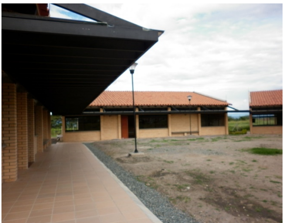
Foto 17. Fotografía de construcción de la sede, zona A desde el módulo 4. Fuente: Néstor Raúl Bolaños Cifuentes. Año: 2010.
