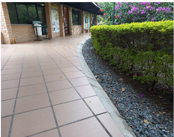
Foto 5. Filtro agua lluvia. Fuente: propia.
