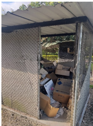
Foto 8. Sitio de acopio de material reciclable localizado en la Zona C. Fuente: propia.
