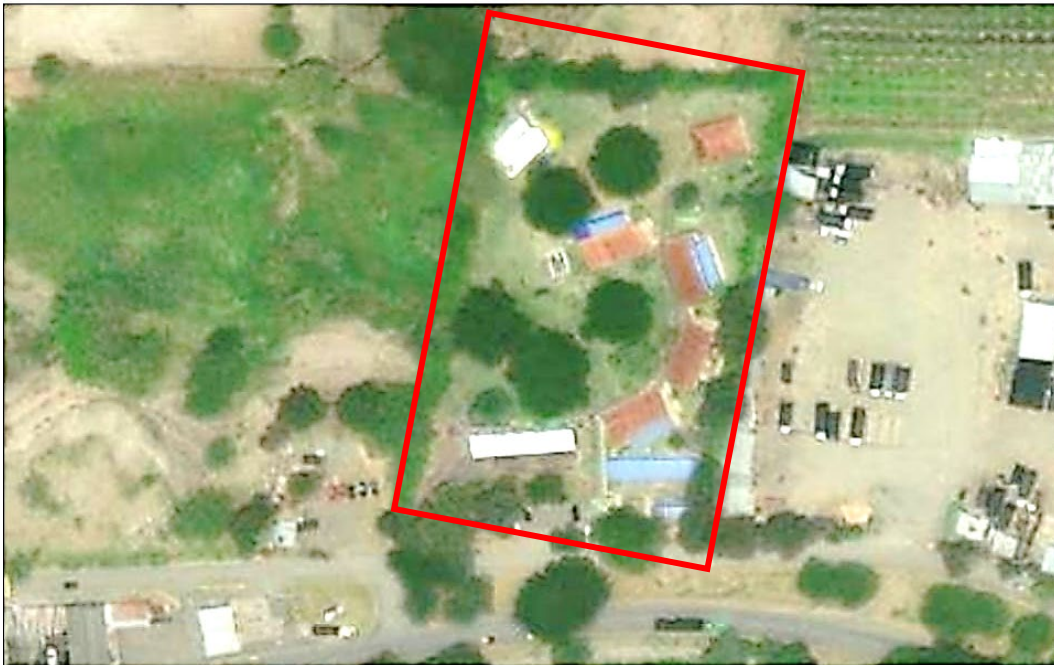
Figura 6. Vista aérea de la DAR BRUT. Fuente: GeoCVC.
