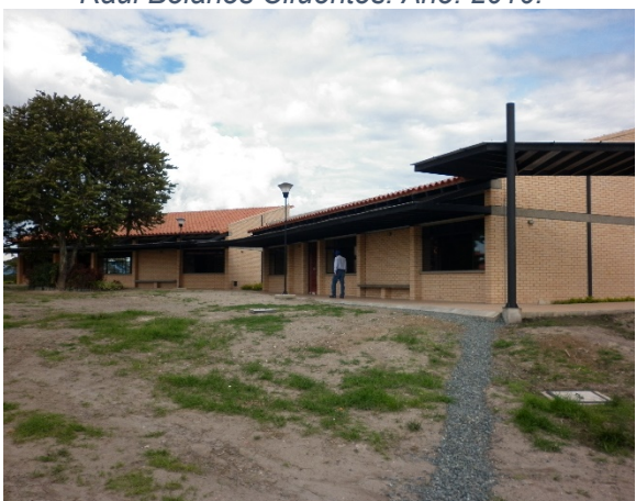
Foto 19. Fotografía de construcción de la sede, zona B, parqueadero. Fuente: Néstor Raúl Bolaños Cifuentes. Año: 2010.
