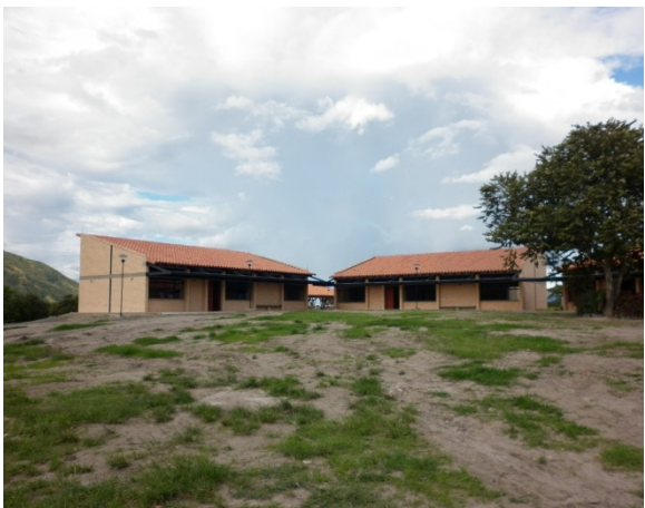
Foto 13. Fotografía de construcción de la sede, zona A módulo 2 y 3. Fuente: Néstor Raúl Bolaños Cifuentes. Año: 2010.
