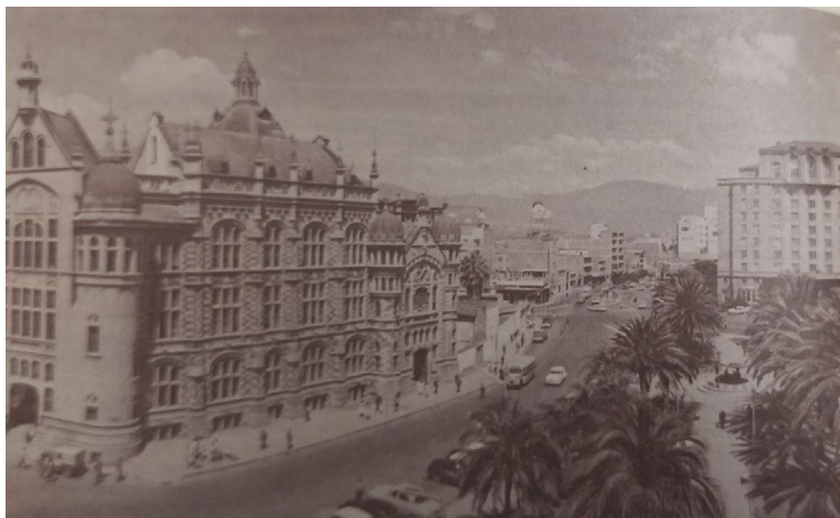
FIGURA 26C. Aspecto final de la cobertura Quebrada Santa Elena
