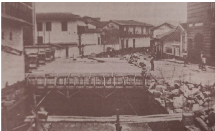
FIGURA 26B. Cobertura Quebrada Santa Elena. Av. Primero de Mayo
