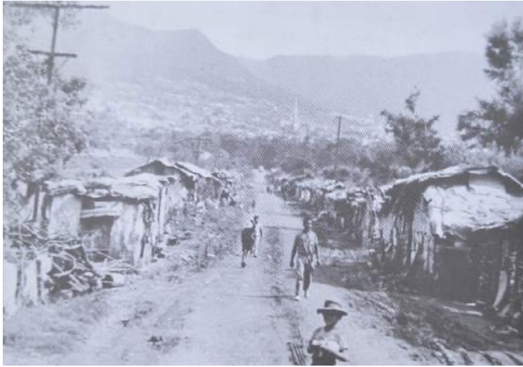
FIGURA 28. Asentamientos subnormales en Medellín (1950)
