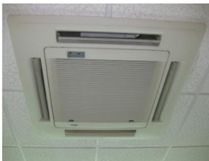
Figura 8. Fan coil tipo Cassete hidrónico
