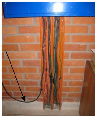
**Figura 29. Canaleta de cables de tablero de potencia.**
