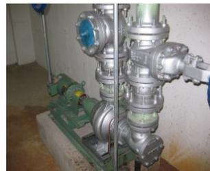
**Figura 5. Bomba de condensación**
