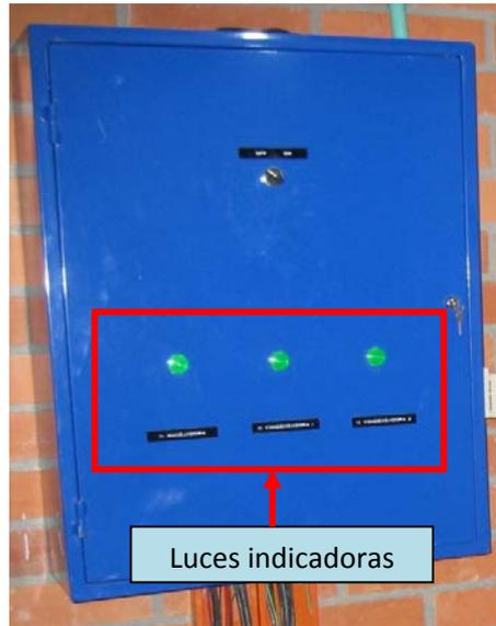
Figura 13. Tablero de potencia con bombillos indicadores
