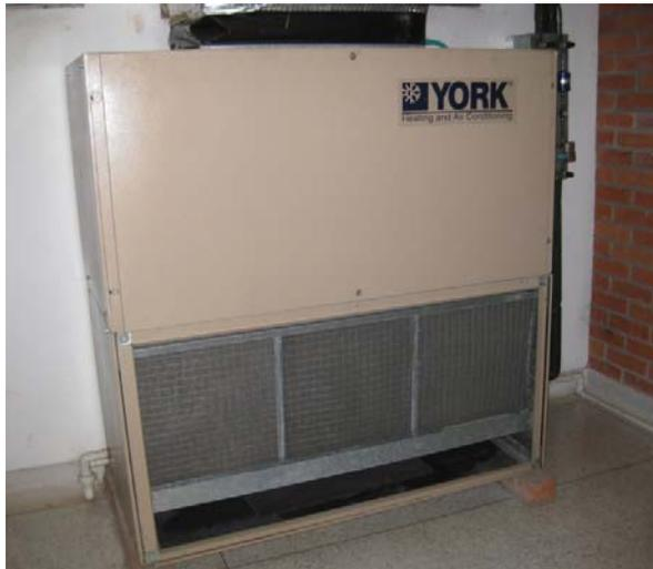
Figura 2. Manejadora de aire circuito primario
