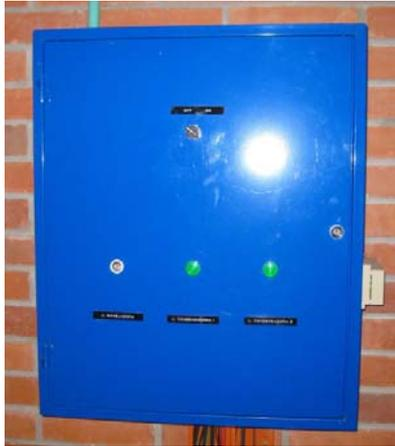
Figura 8. Tablero de potencia circuito primario
