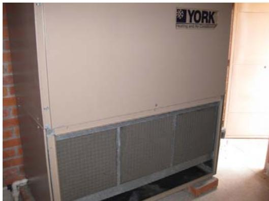
Figura 7. Manejadora de aire circuito secundario
