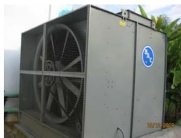
**Figura 26. Torre de enfriamiento después**
