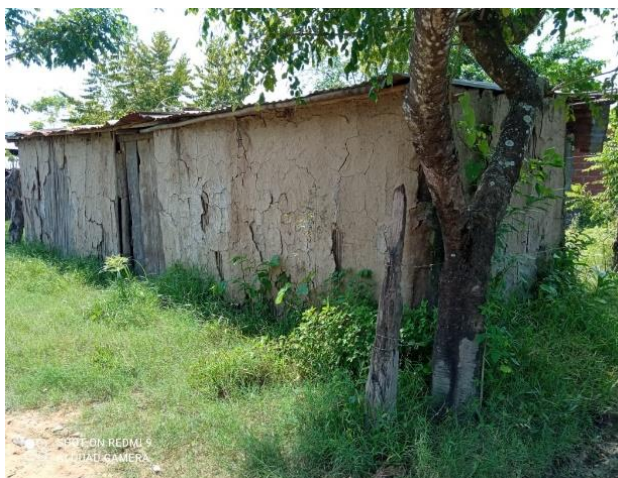
Figura 23 Casas zona rural
