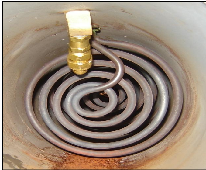
Figura 11: Filtro del sistema de aspersión [9]
