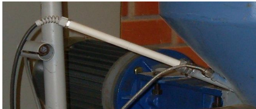
Figura 9: Higrómetro y RTD PT100 Ubicados en la Tolva
