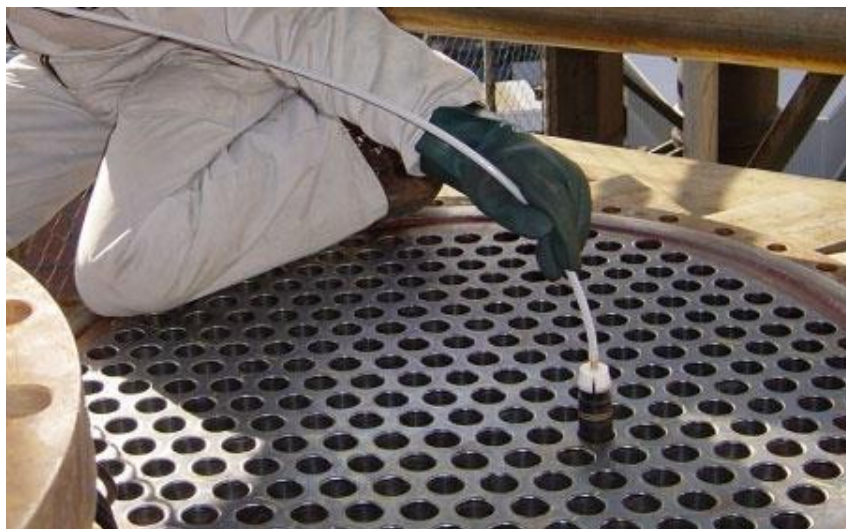
Figura 7. Inspección por corrientes inducidas para el haz de tubos.
