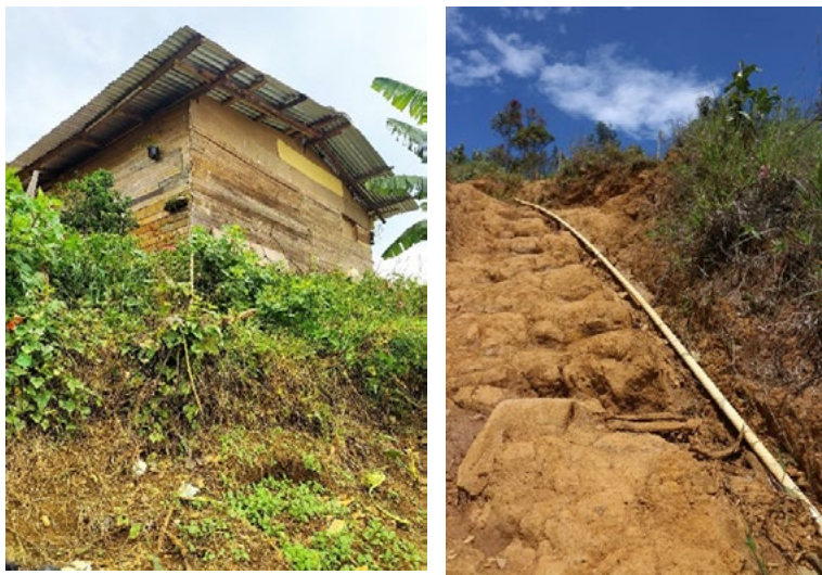
Figura 22. Viviendas laderas bordes urbanos ladera nororiental Medellín (2019)
