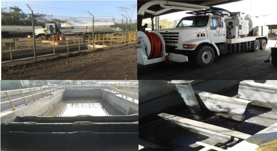
Figura 15. Mantenimiento del sistema de recirculación de agua con equipo especializado. *Fuente: autor*
