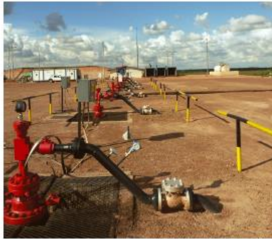
Figura 15. Montaje final en campo
