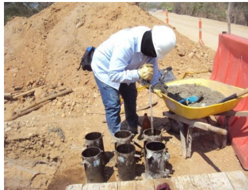
Imagen 17: Toma de muestras de concreto.
