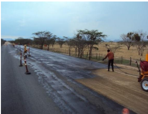
Imagen 10: Imprimación con emulsión asfáltica de rotura lenta
