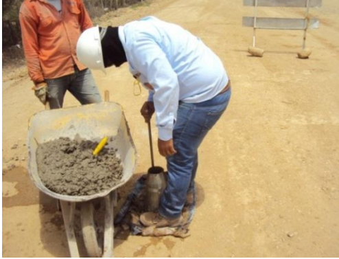
Imagen 12: Ensayo de asentamiento de concreto (Slump)
