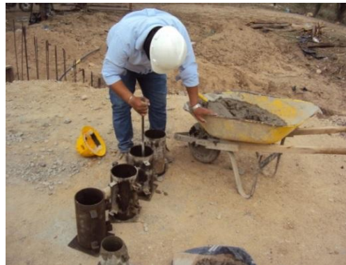
Imagen 16: Toma de muestras de concreto.
