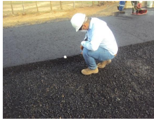
Imagen 9: Medición de la temperatura de la mezcla asfáltica extendida
