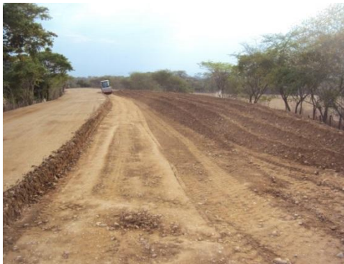
Imagen 2: Cajeo realizado para corregir fallos en material de terraplén
