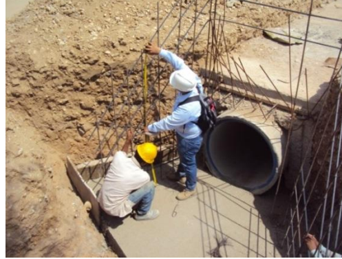
Imagen 15: Medición de cantidades de obra (acero de refuerzo)
