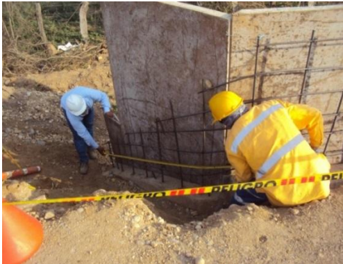
Imagen 14: Medición de cantidades de obra (acero de refuerzo)
