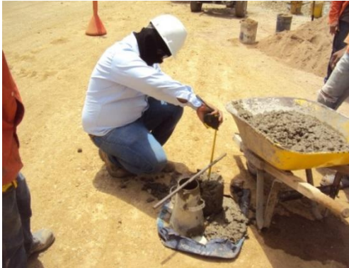
Imagen 13: Ensayo de asentamiento de concreto (Slump)
