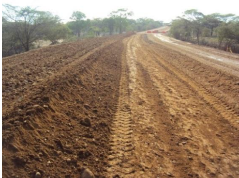
Imagen 5: Cajeo realizado para corregir fallos en material de terraplén
