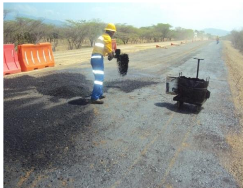
Imagen 11: Colocación de mezcla asfáltica para proteger la imprimación
