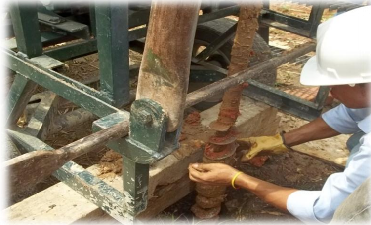
Imagen 6. Ejecución del SONDEO 3, rotación localizada en la mitad del lote (Autor).
