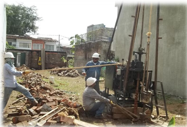
Imagen 7. Ejecución del SONDEO 3, SPT localizado en la mitad del talud (Autor).
