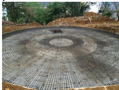
Acero de refuerzo
