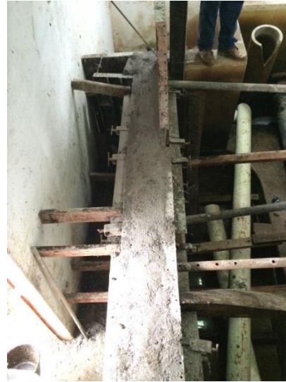
Fundida del concreto
