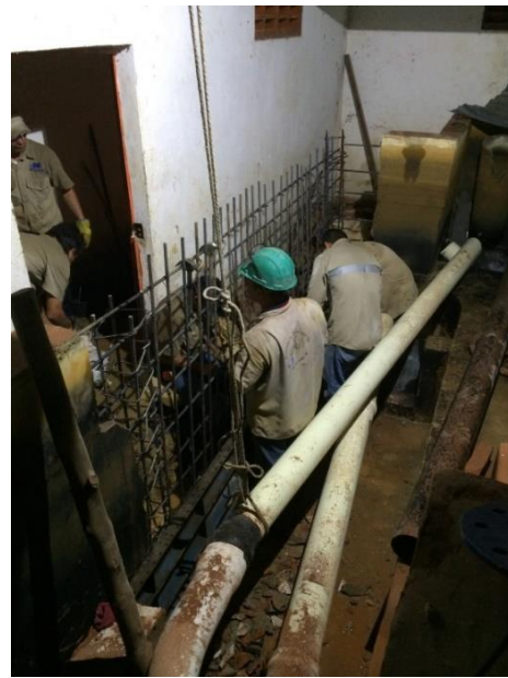
Armado de doble parrilla de acero de 1/2"
