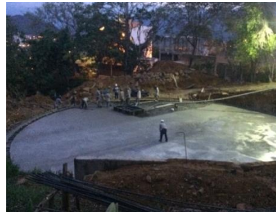
Placa de concreto
