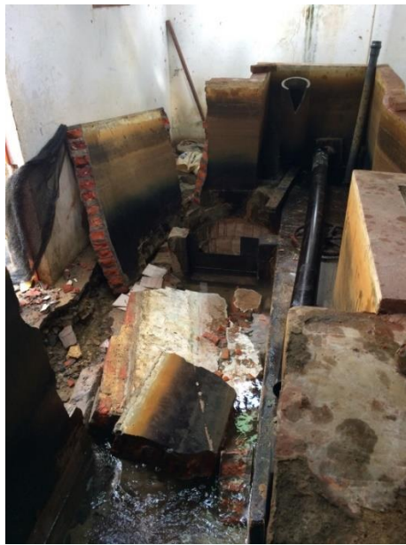
Muro colapsado
