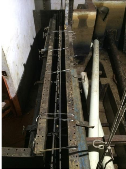
Armado de formaleta
