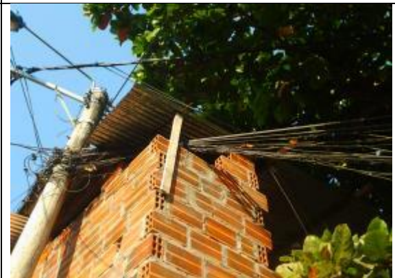
Figura 12. Vivienda, Asentamiento Informal Altos del progreso.
