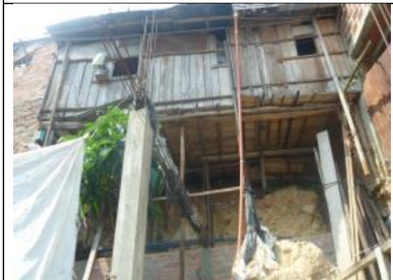
Figura 11. Vivienda, Asentamiento Informal Altos del progreso.
