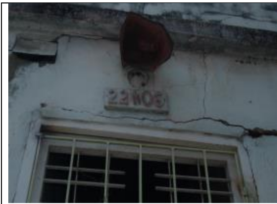
Figura 18. Vivienda, Asentamiento Informal Urbanización las Olas
