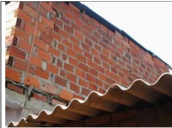
Figura 32. Mampostería confinada Villa María
