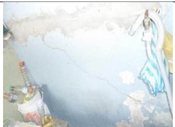
Figura 19. Vivienda, Asentamiento Informal Urbanización las Olas
