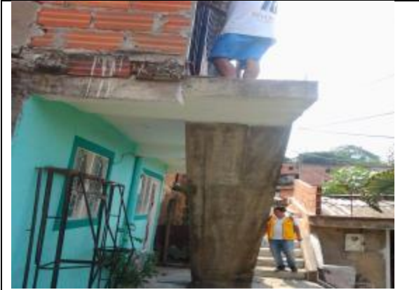
Figura 17. Escalera de vivienda, Asentamiento Informal Altos del progreso .
