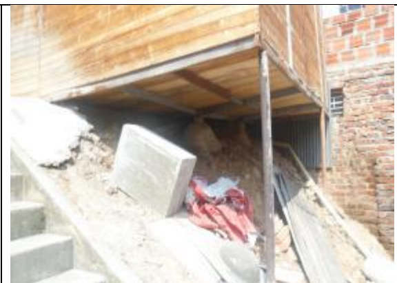
Figura 10. Vivienda, Asentamiento Informal Altos del progreso.
