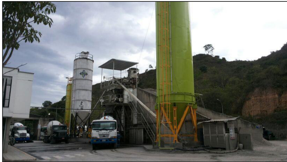
Imagen 1. Planta Prevesa s.a.s
