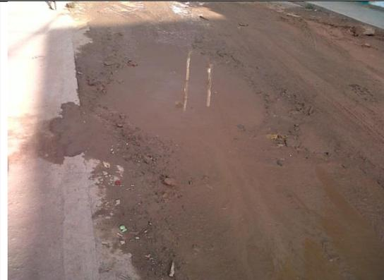
Figura 42. Acumulación de agua en la vía del ASENTAMIENTO HUMANO BRISAS DE PROVENZA
