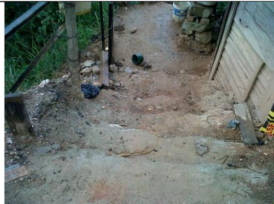
Figura 45. Peatonal sin mortero después de la lluvia.
