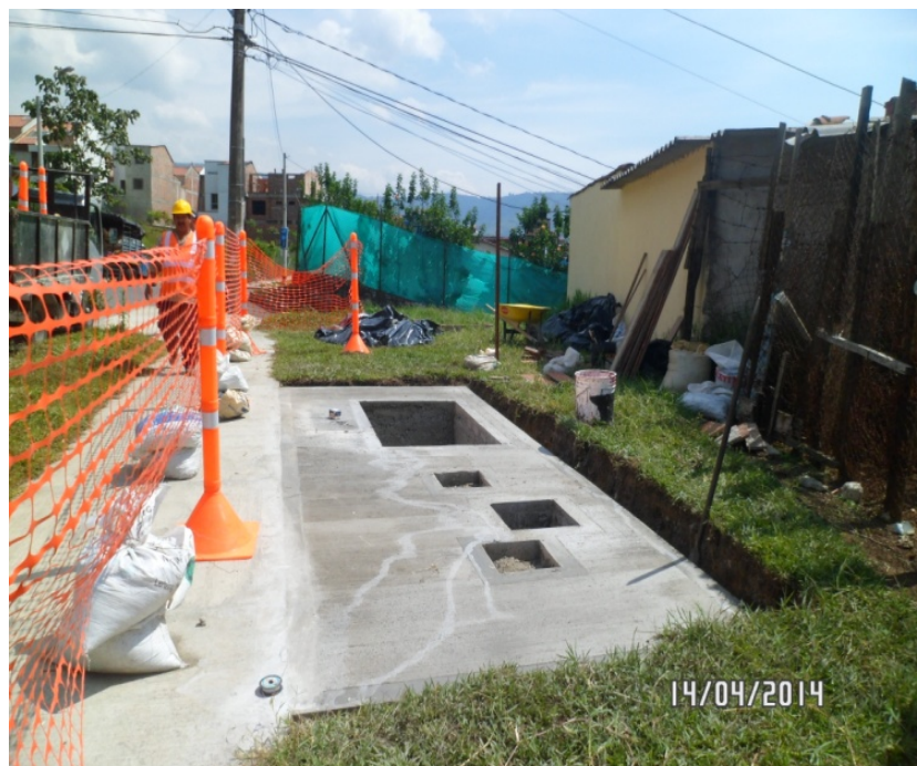
Figura 12. Acabado de piso en concreto Caseta (Autor)
