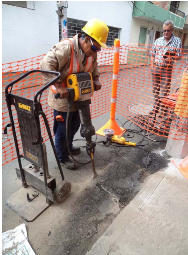
Figura 5. Demolición de Pavimento Cimentación Tótem (Autor)
