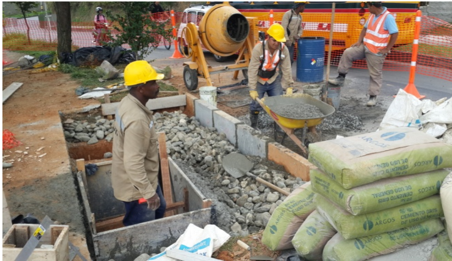
Figura 49. Vaciado de Placa Anden Caseta (Autor)
