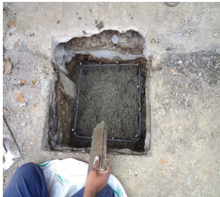
Figura 6. Fase Uno de Cimentación Tótem (autor)
