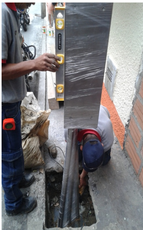
Figura 48. Instalación de Paradero Tipo Tótem (Autor)
