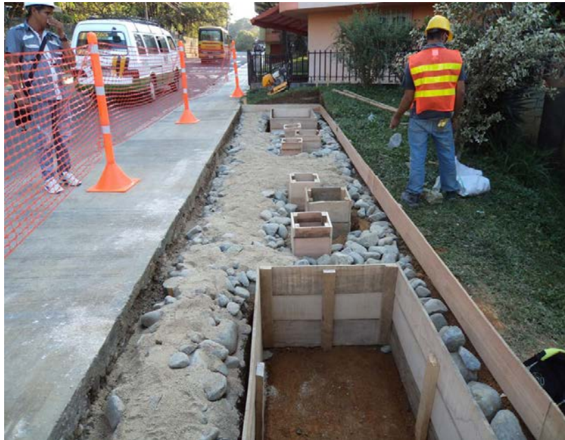
Figura 11. Estructura de andén de Concreto para Caseta (Autor)
