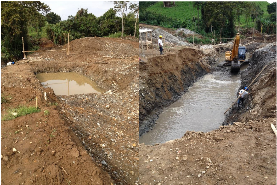
Figura 12. Trabajo de Retroexcavadora en el Box Coulvert. Fuente Propia.
