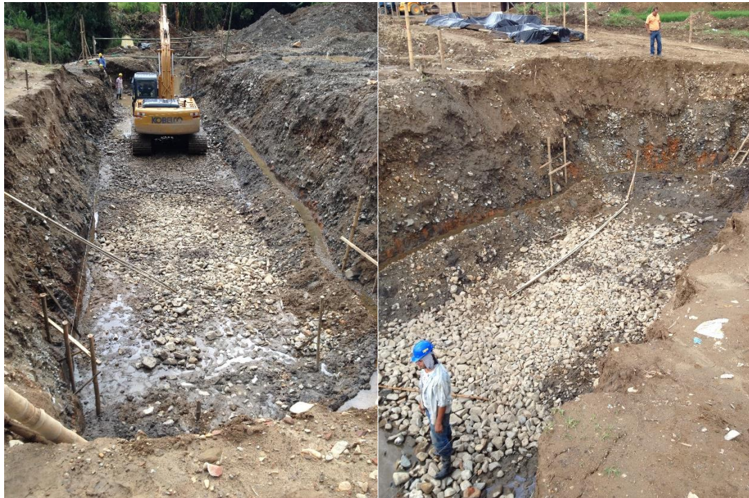
Figura 14. Colocación de roca en la base de la Excavación. Fuente Propia.
