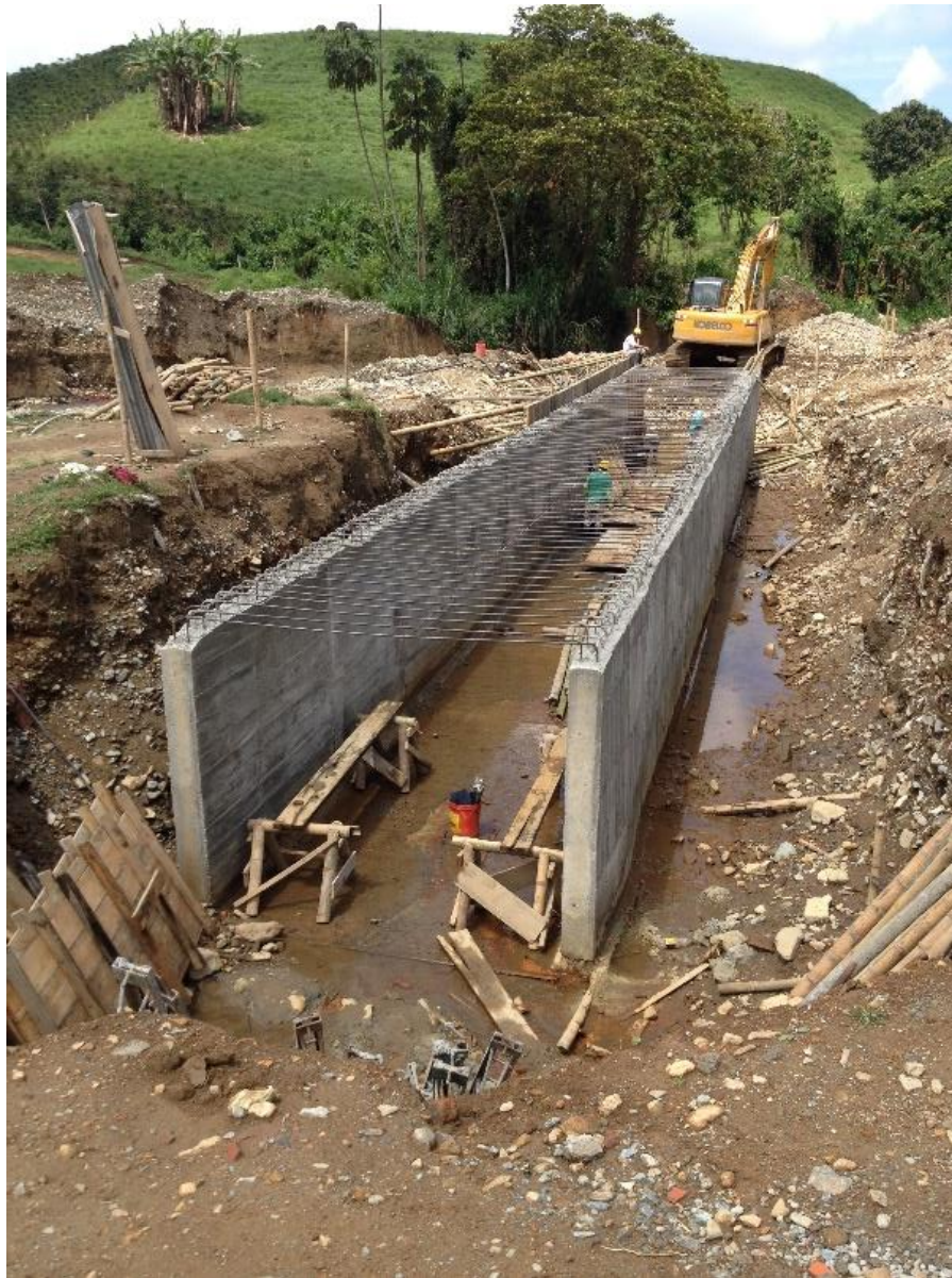
Figura 20. Muros Laterales Box Coulvert. Fuente Propia.
