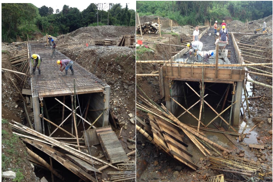
Figura 21. Armado de la Formaleta y Vaciado de Concreto. Fuente Propia.
