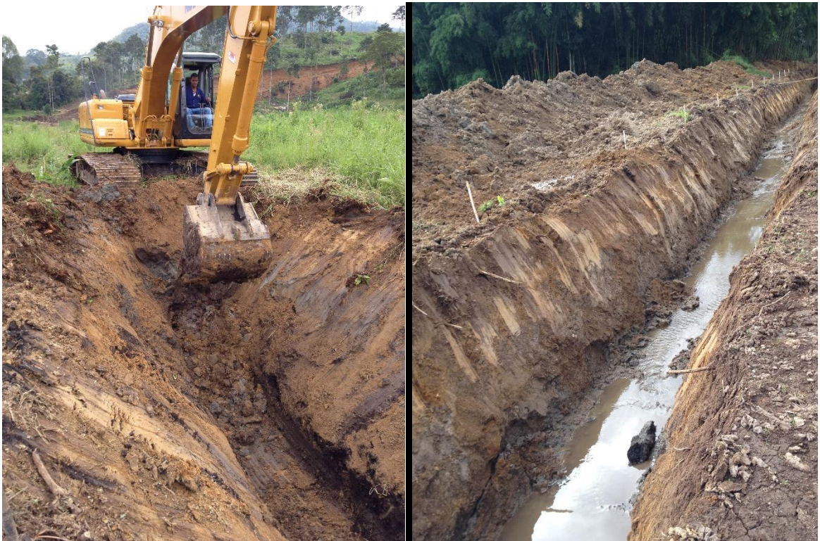
Figura 24. Excavaciones del canal de drenaje provisional. Fuente Propia.
