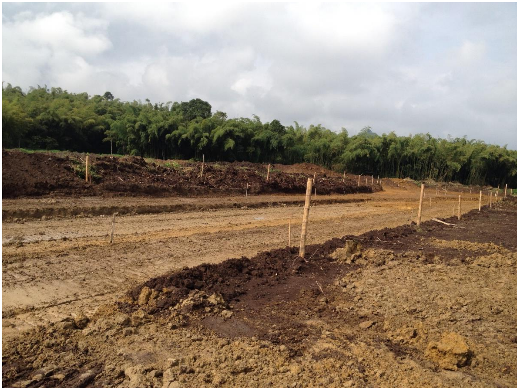
Figura 31. Delimitación de Vía. Fuente Propia.
