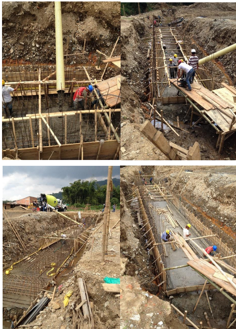
Figura 17. Fundición de la losa Box Coulvert. Fuente Propia.
