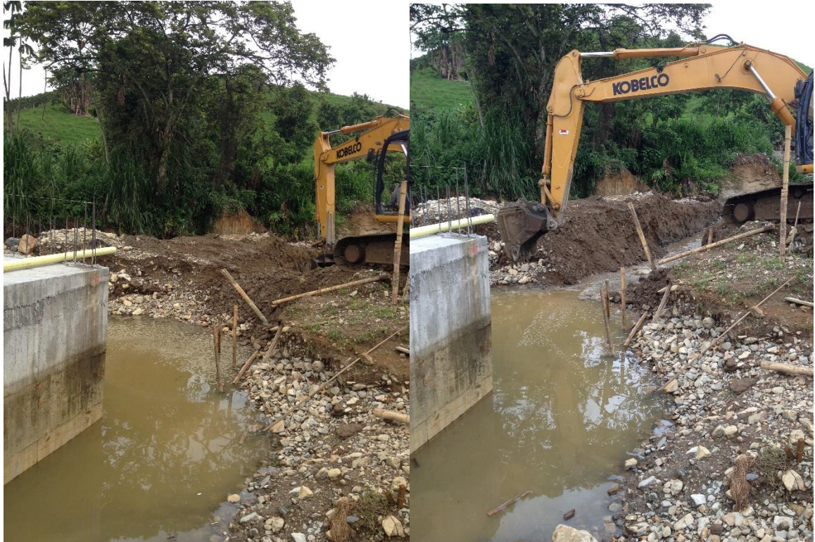
Figura 26. Excavación de Material para desvío de quebrada. Fuente Propia
