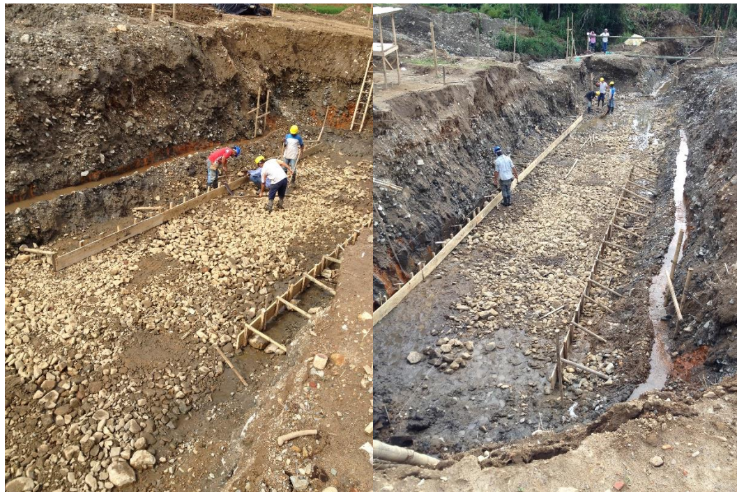
Figura 15. Instalación de formaleta del solado. Fuente Propia.
