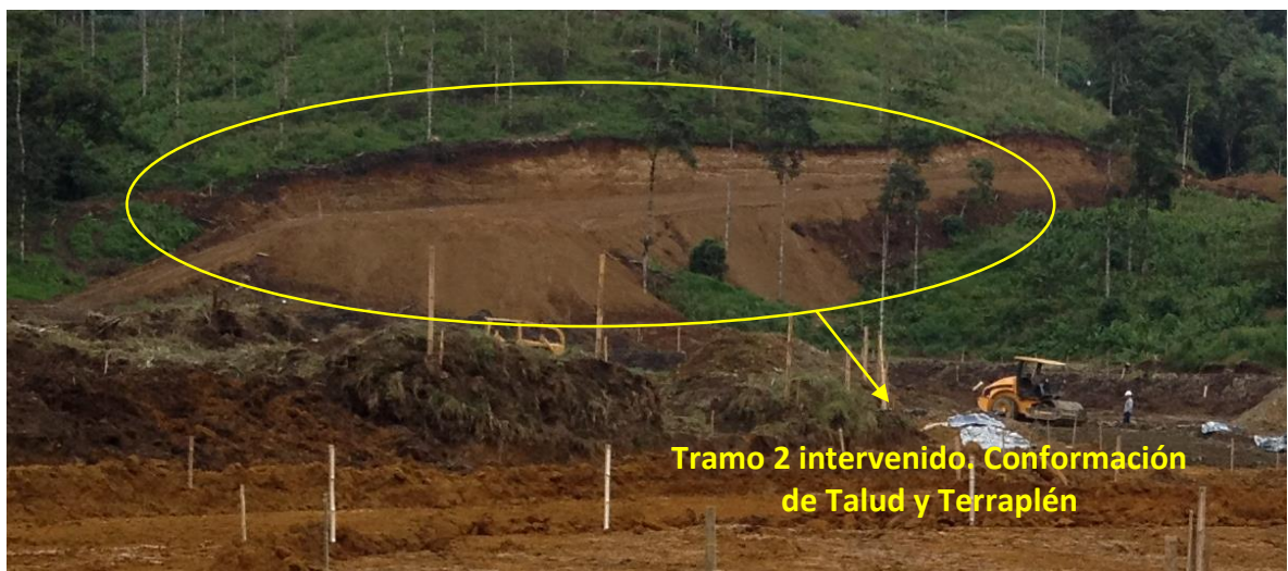
Figura 29. Conformación de Talud y Terraplén. Fuente Propia
