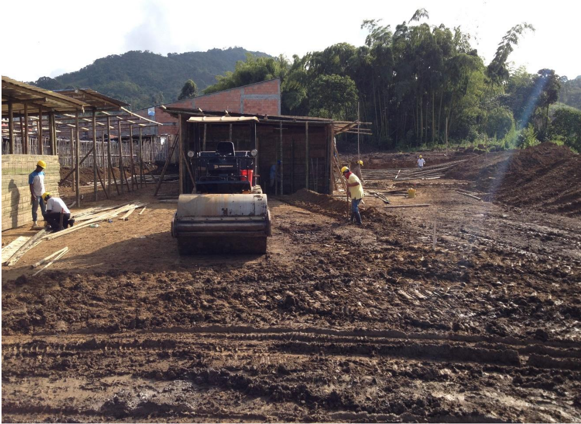
Figura 6. Construcción del Campamento. Fuente Propia.
