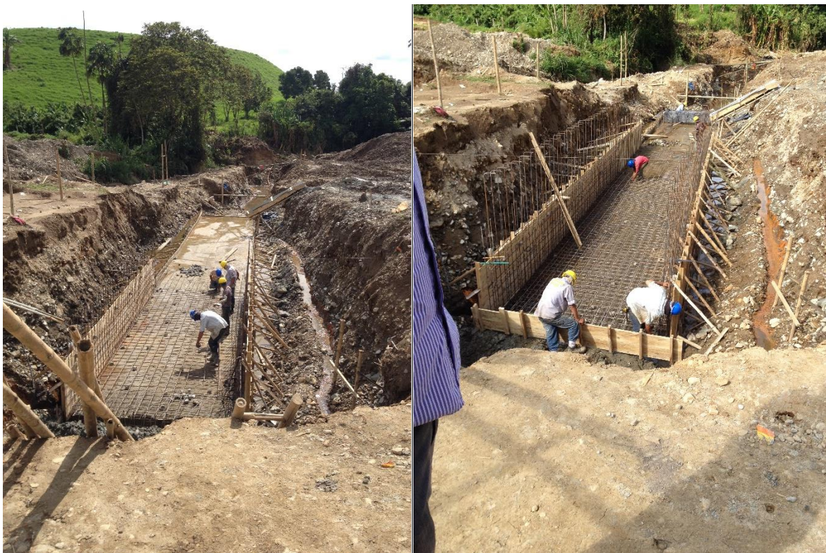
Figura 16. Armado de acero losa inferior de la estructura. Fuente Propia.
