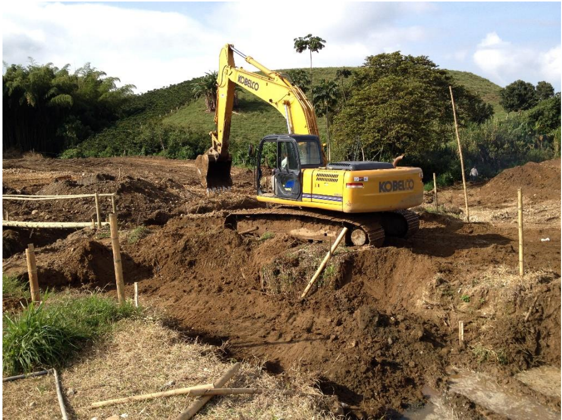
Figura 11. Inicio de Excavaciones Box Couvert. Fuente Propia.
