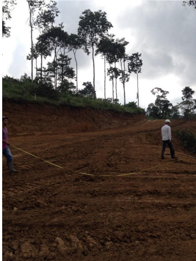
Figura 30. Mediciones conformación de Terraplén. Fuente Propia
