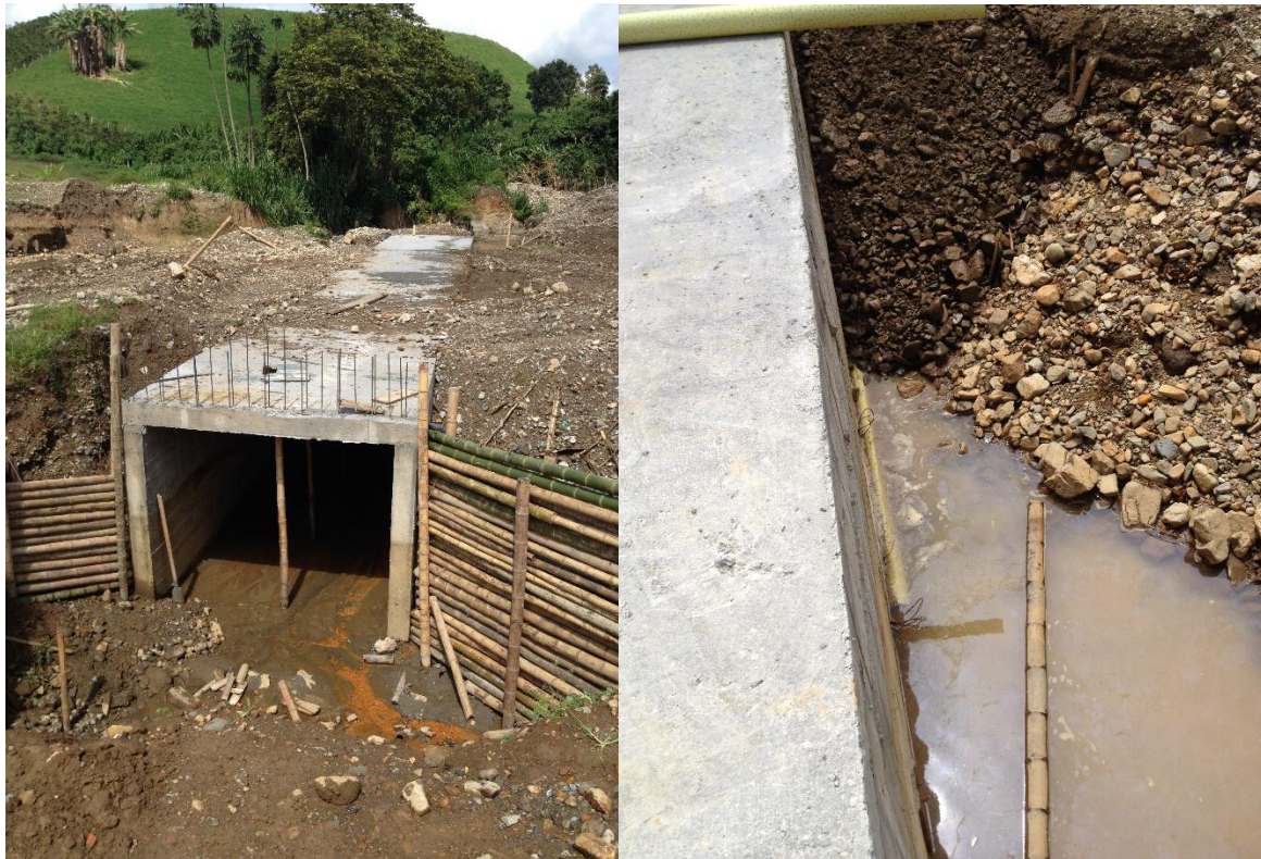
Figura 27. Aletas Provisionales e Instalación de tubo perforado. Fuente Propia
