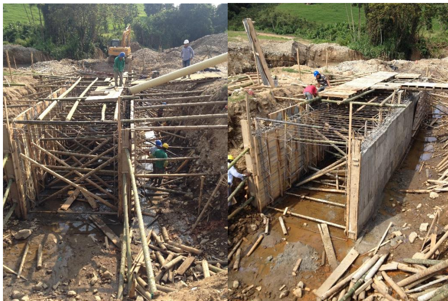
Figura 18. Instalación de Formaleta y Vaciado de Concreto. Fuente Propia.
