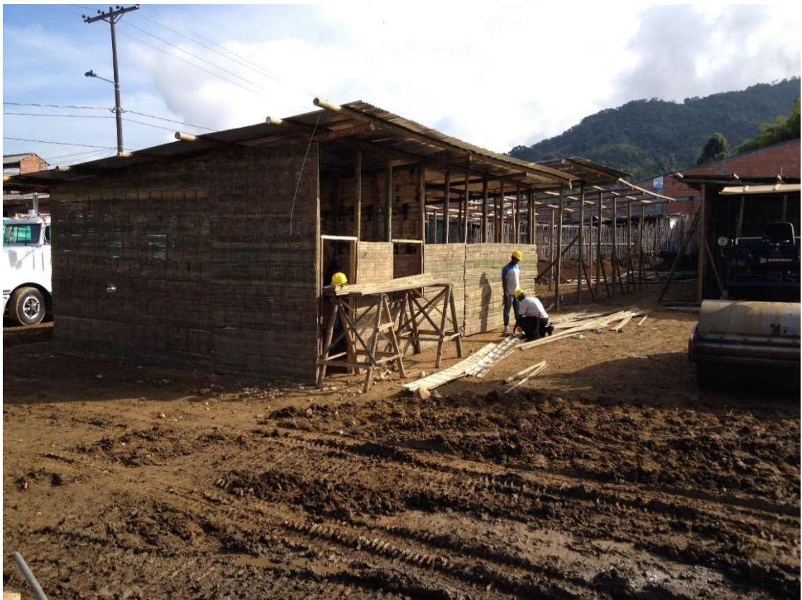
Figura 5. Campamento de Obra. Fuente Propia.
