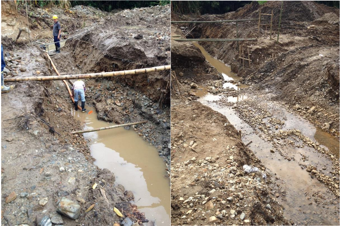
Figura 13. Bombeo de Agua acumulada en la Excavaciones. Fuente Propia.
