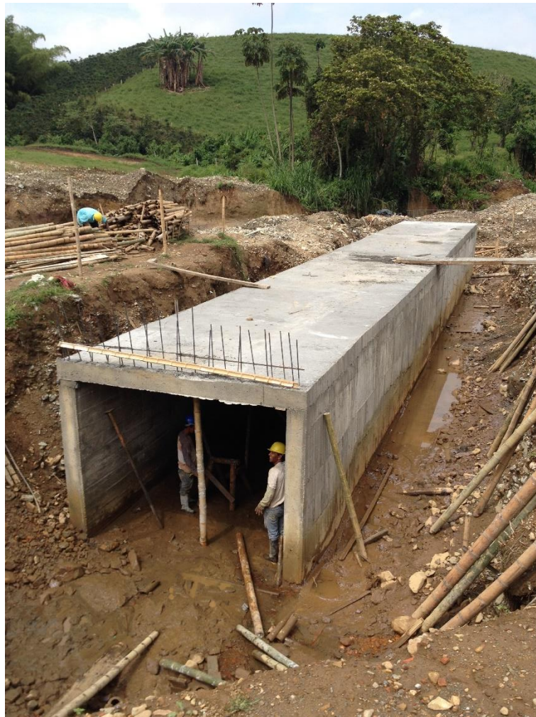
Figura 22. Estructura del Box Couvert. Fuente Propia.
