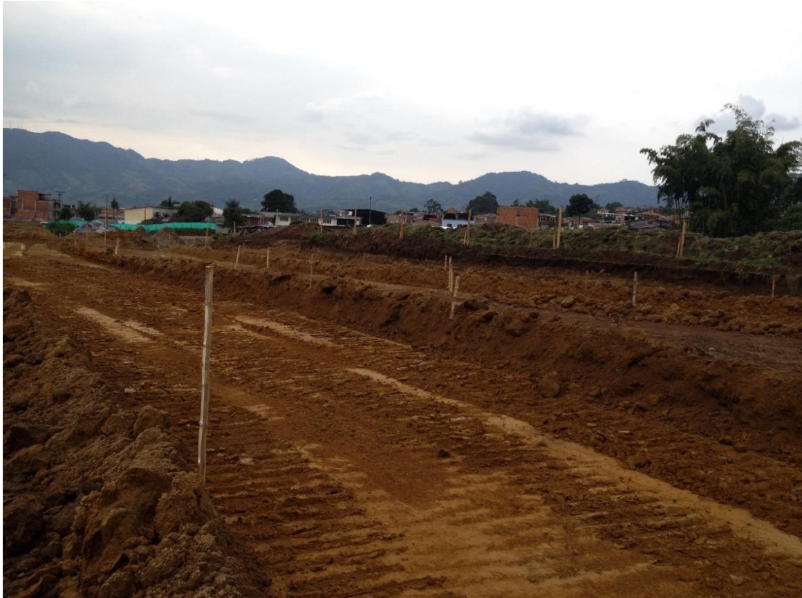
Figura 23. Conformación de calzada. Fuente Propia.
