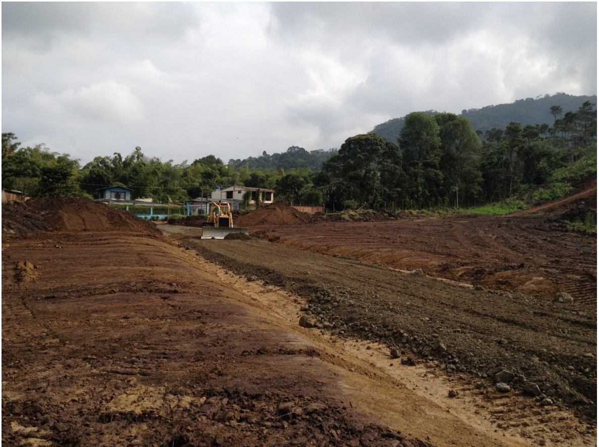
Figura 32. Extendido de Afirmado sobre la vía. Fuente Propia.
