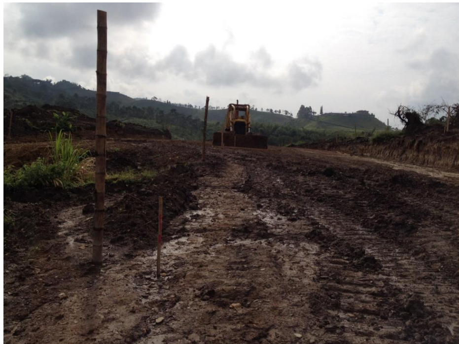
Figura 8. Descapote terreno conformación de calzada. Fuente Propia.
