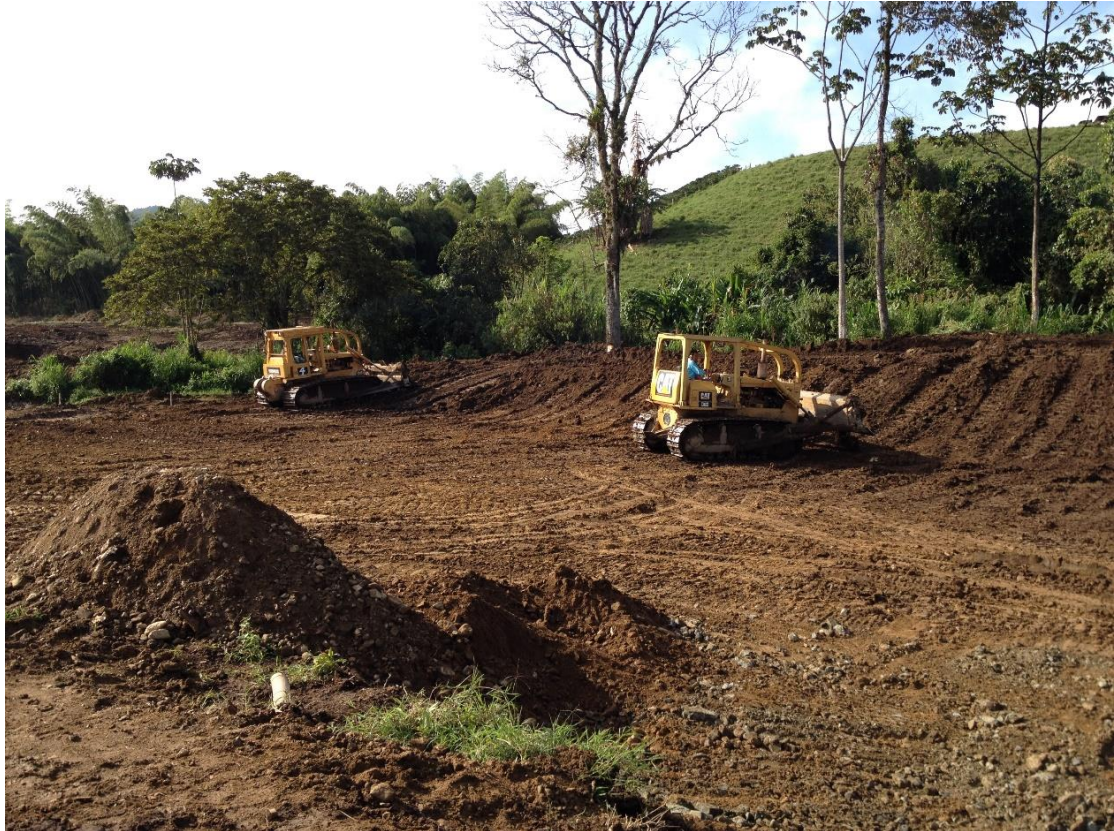
Figura 4. Descapote del lote. Fuente Propia.
