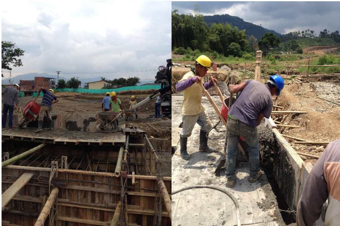
Figura 19. Paso Carreteable. Fuente Propia.
